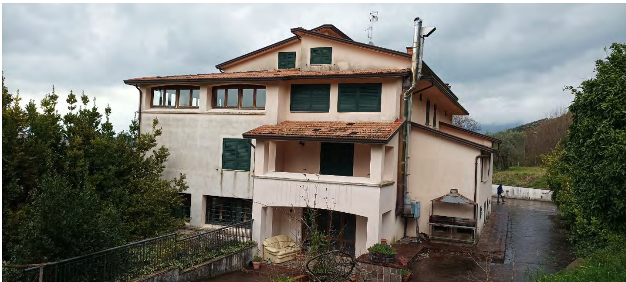
VISTA DA SUD, DALL'AREA ESTERNA DEL FABBRICATO RURALE
