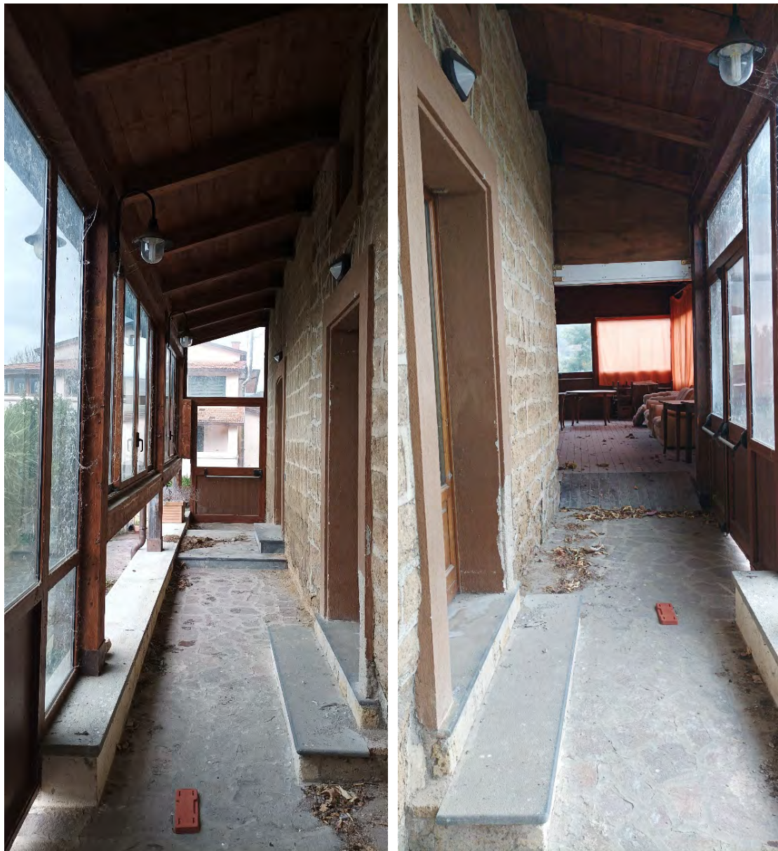
INTERNO VERANDA LATO OVEST
