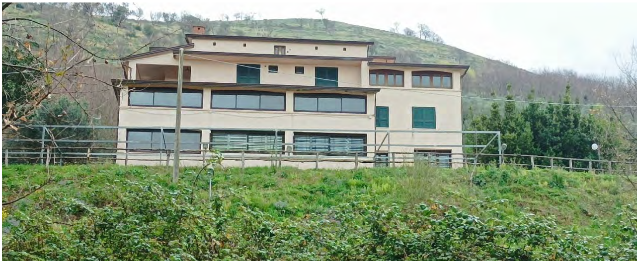
VISTA DA OVEST, DAI TERRENI SOTTOSTANTI
