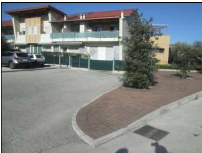
Foto n. 11 Vista posti auto esterne
