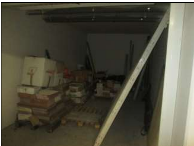
Foto n. 5 Vista garage piano S1.
