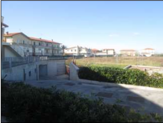
Foto n. 1 Vista rampa di accesso pian. S1.
