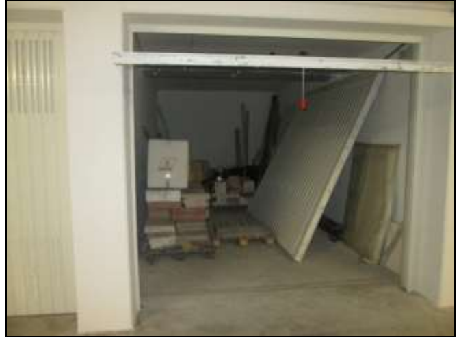
Foto n. 4 Vista garage piano S1.
