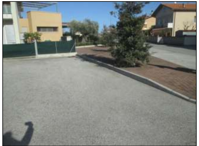
Foto n. 10 Vista posti auto esterne
