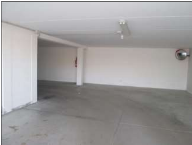
Foto n. 3 Vista spazio di manovra.
