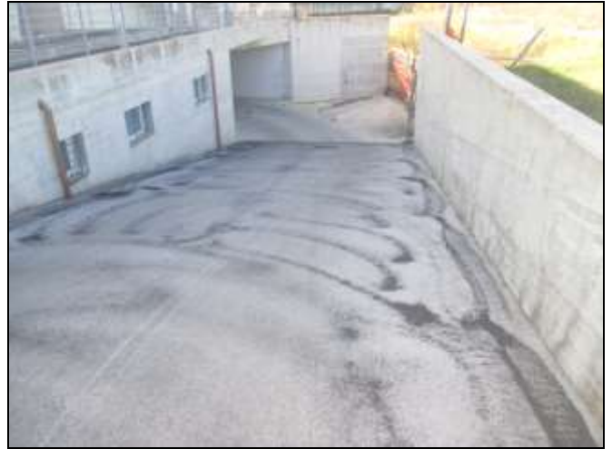
Foto n. 2 Vista rampa di accesso pian. S1.
