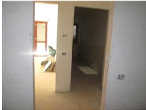
vista camera e soggiorno unità immobiliare
