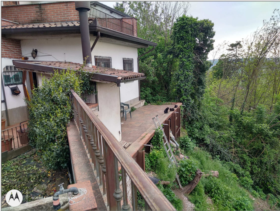
Vista su costruzioni interne al cortile e opere di terrazzamento a sostegno del fabbricato, insistenti su mappali 1151 e 264 [opere prive di autorizzazione edilizia]
