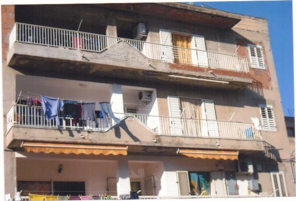
3. Veduta del prospetto su via Bramante dell'appartamento pignorato.
