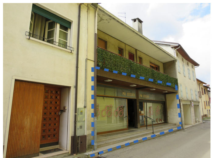
Vista dell'unità immobiliare verso la Via pubblica
