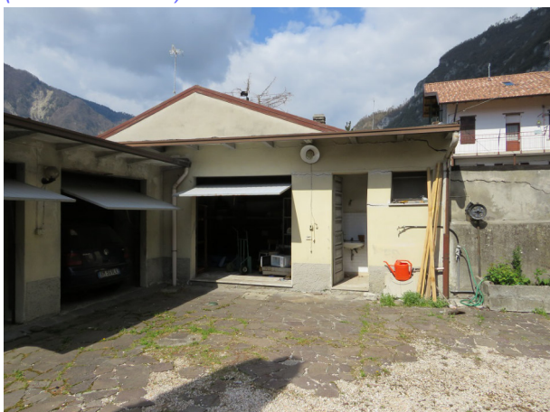
Vista frontale Magazzino
