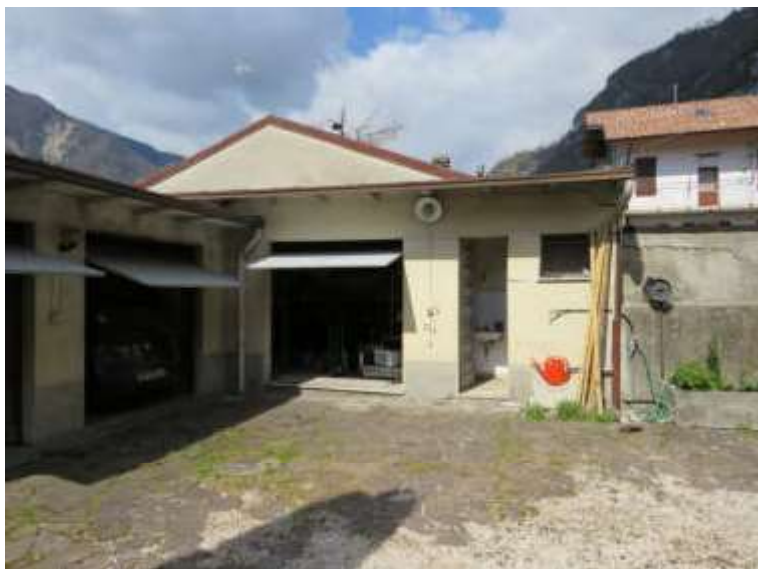
Vista frontale Magazzino
