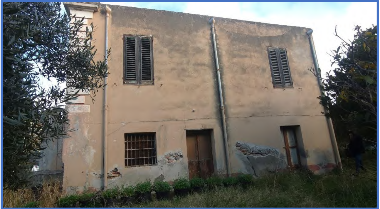
Foto 16 – Prospetto lato sud.
