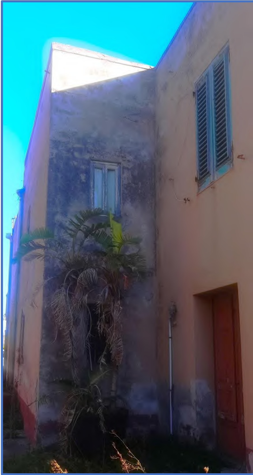
Foto 12 – Portoncino di ingresso al sub 4.
