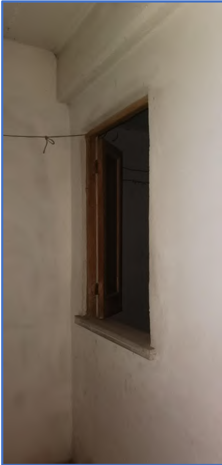
Foto 54 – Finestra all'interno dell'ingresso unità immobiliare individuata con il sub 4.
