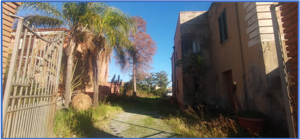
Foto 5– Ingresso alla corte sul lato nord del fabbricato dalla Via San Paolino.
