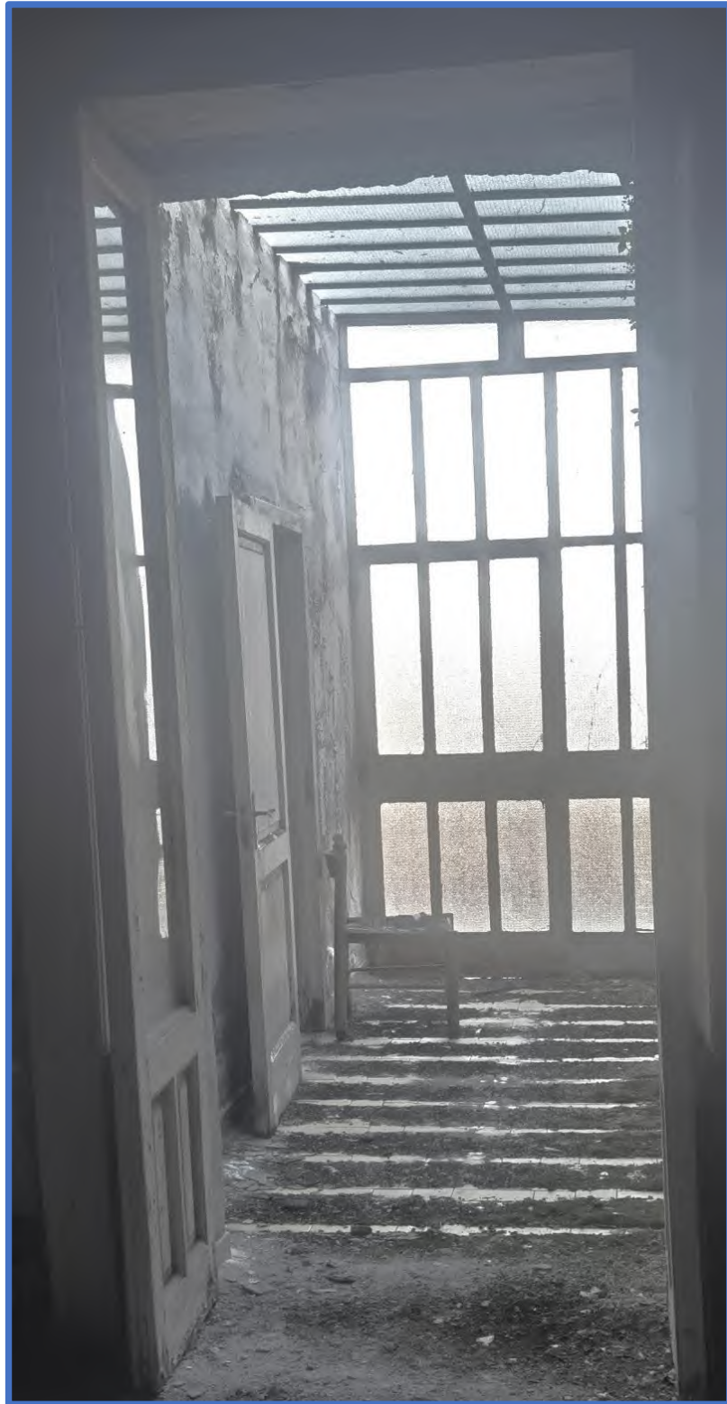
Foto 30 – Vista corpo aggiunto dei servizi.
