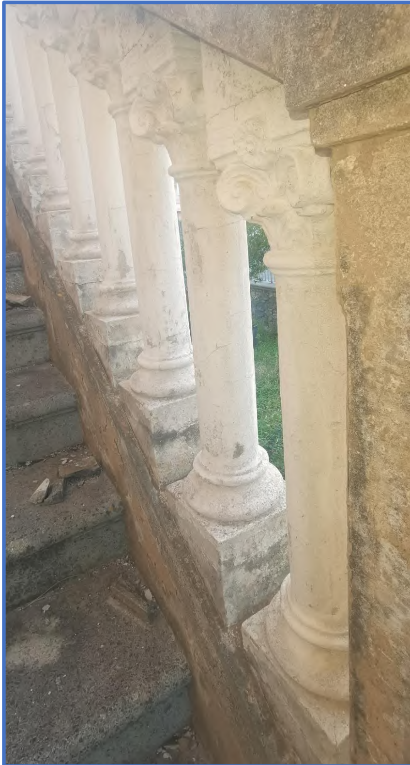
Foto 9 – Scala esterna. Particolare parapetto.
