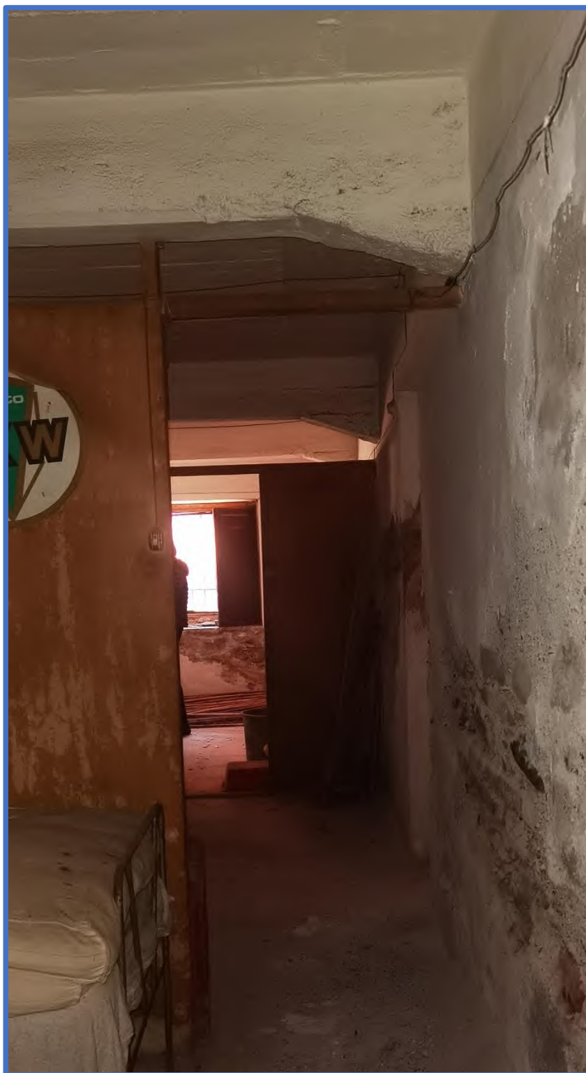
Foto 55 –Interno dell'unità immobiliare. Si notino le tramezzature realizzate con pannellature di legno.
