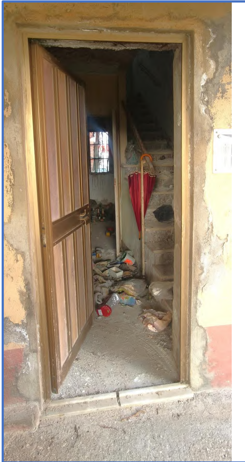
Foto 39 – Vista ingresso al vano scale dal piano terra.
