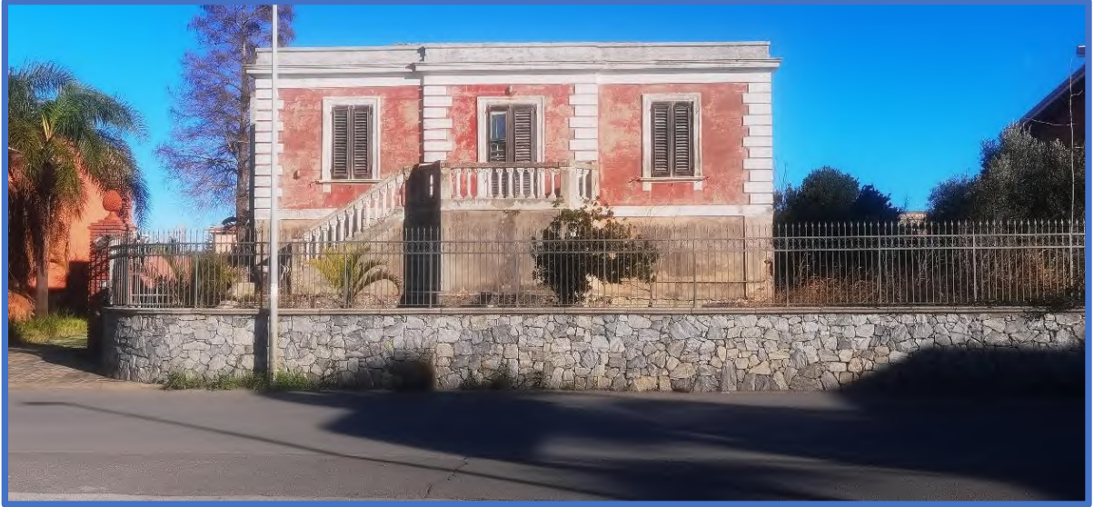
Foto 3 – Prospetto principale con esposizione ad ovest. Il corpo centrale inquadra l'ingresso al Piano primo.
