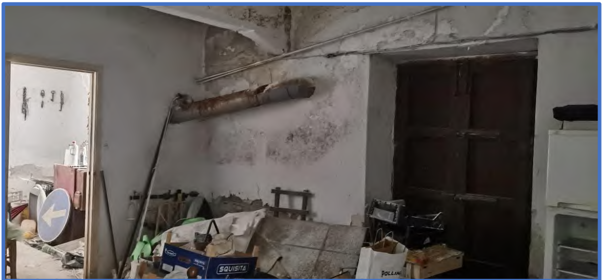
Foto 47 – Vista del locale deposito.
