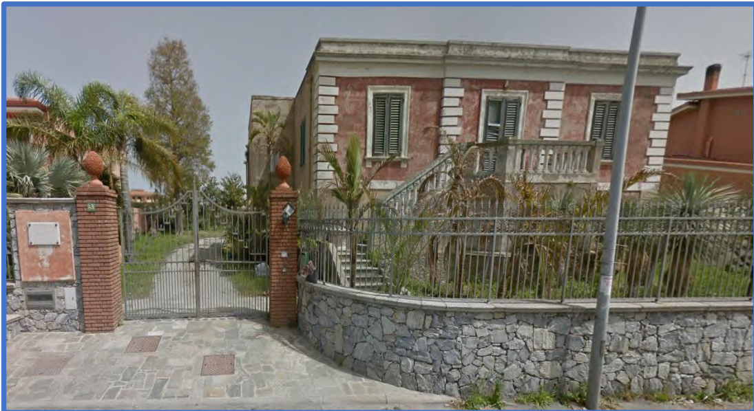
Foto 2 – Prospetto principale, con cancello di ingresso alla corte dalla Via San Paolino.
