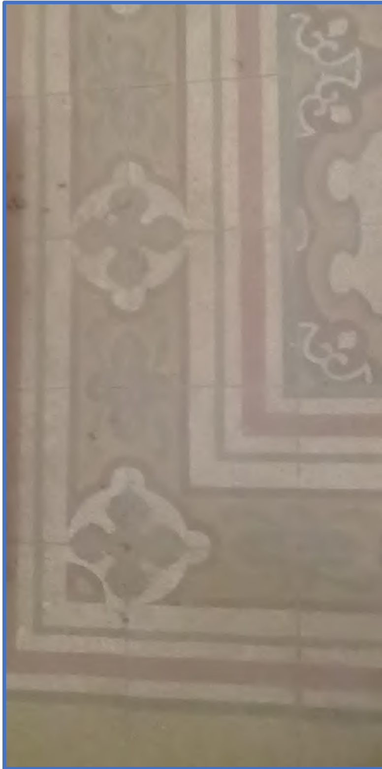
Foto 35 – Particolare pavimentazione con cementine.
