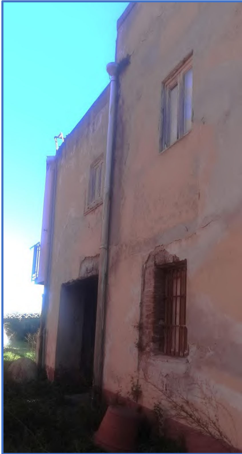
Foto 13 – Prospetto lato nord. Si giunge al portico.
