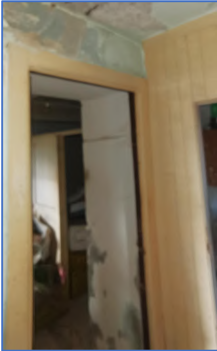
Foto 41 – Vista porta di accesso al sub 3 dal vano scala.
