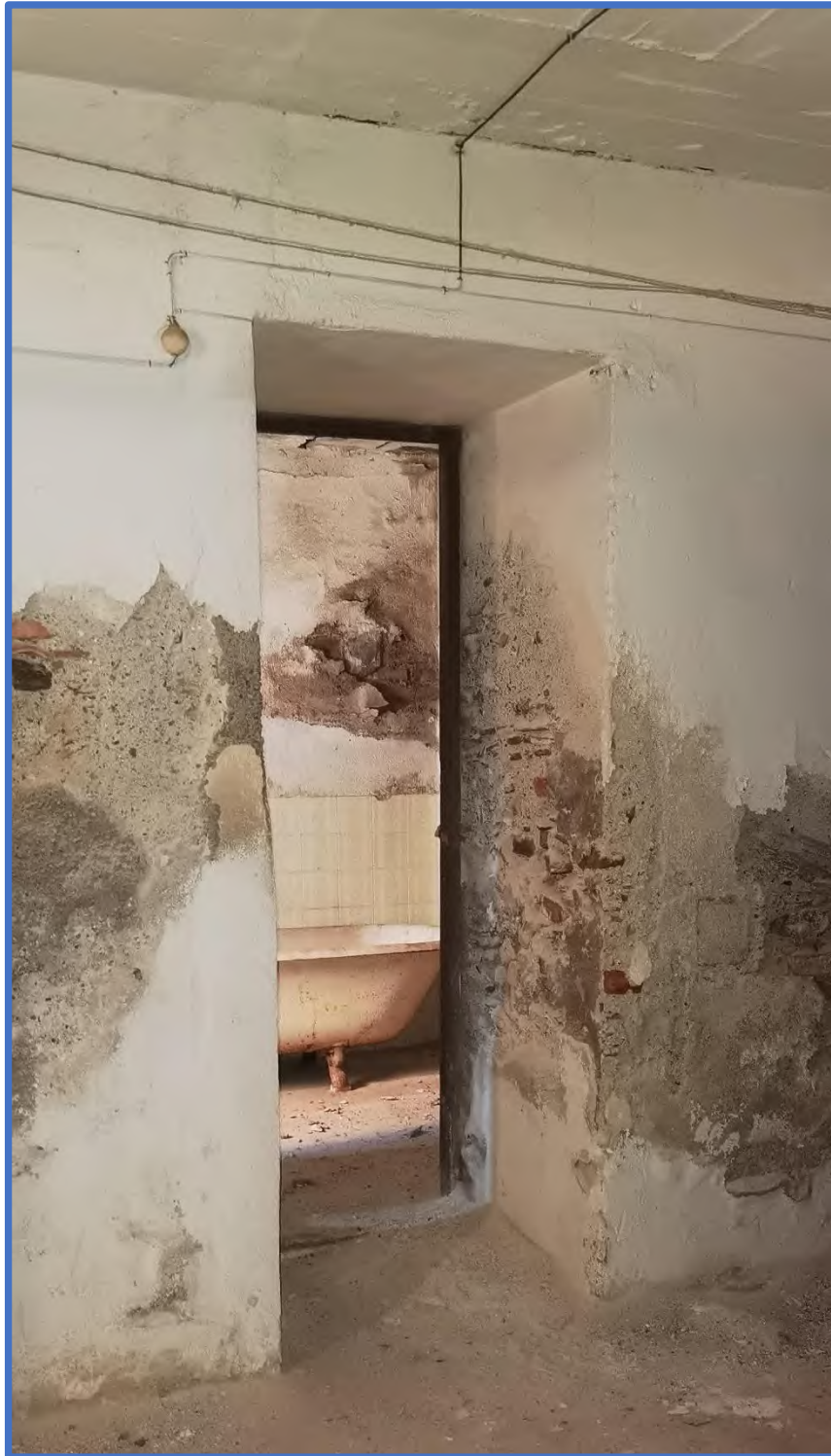
Foto 57 – Porta di accesso al bagno .
