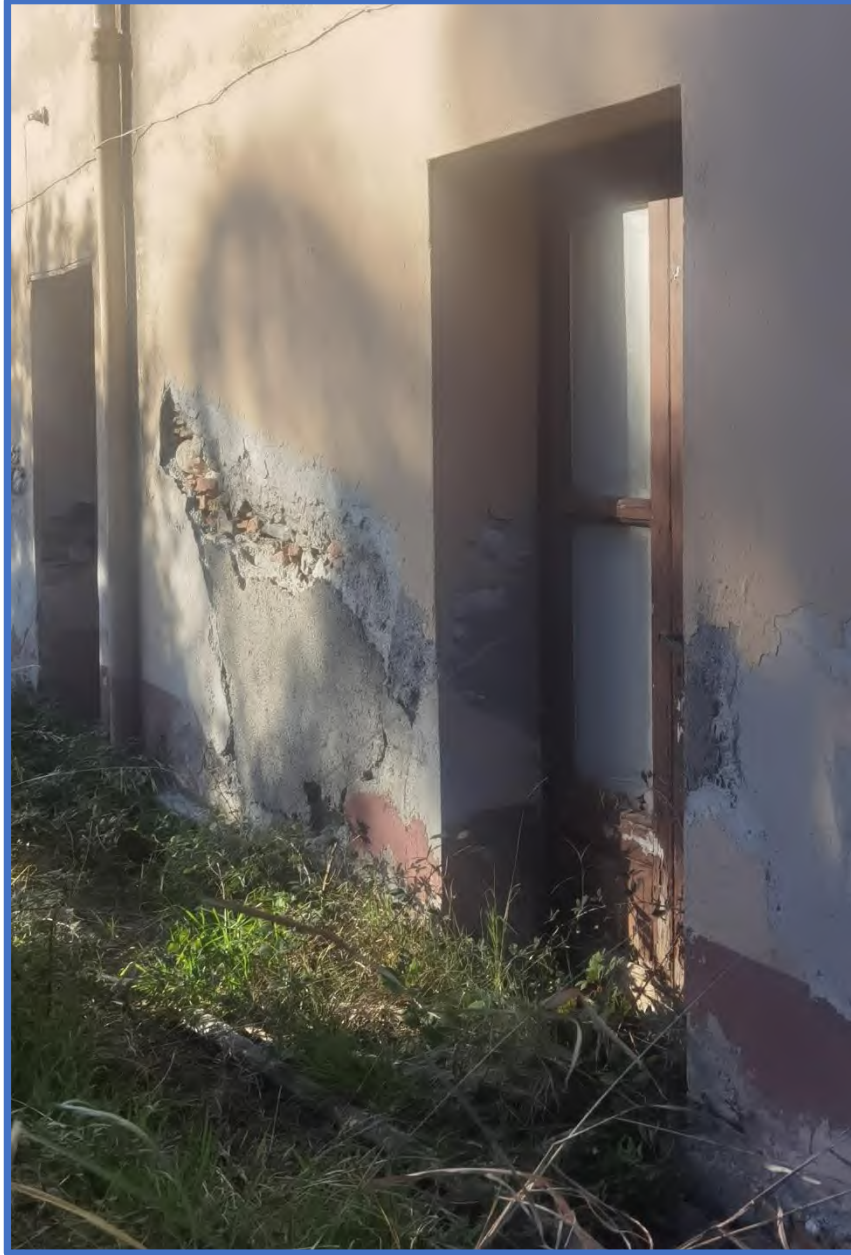
Foto 42 – Vista porta di accesso al sub 3 dal lato sud del fabbricato.
