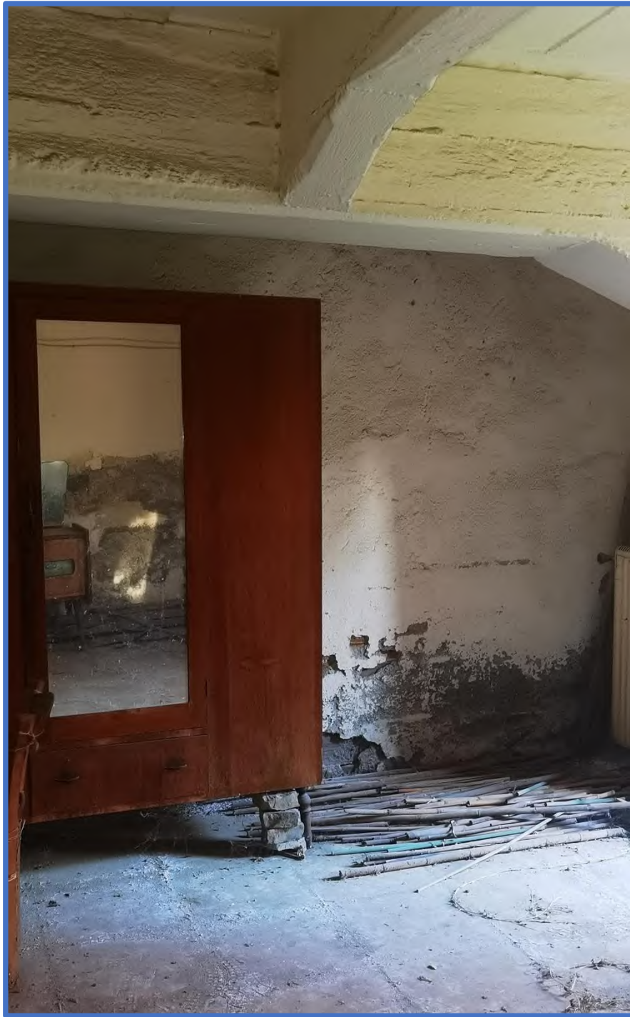
Foto 61– Camera esposta a sud, dalla quale è possibile uscire nella corte esterna. Altri particolari della struttura delle travi rinforzate.
