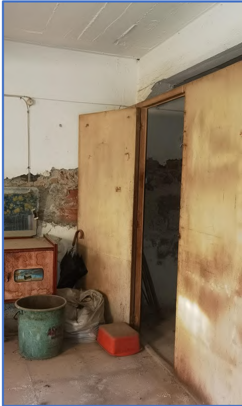
Foto 60 – Particolare pannellatura di divisione in cui sono ricomprese le porte..
