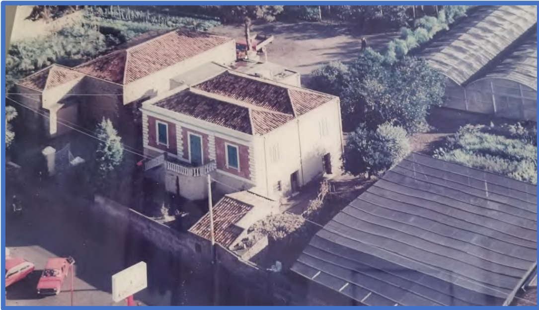
Foto 63- Vista dello stato dei luoghi originario.
