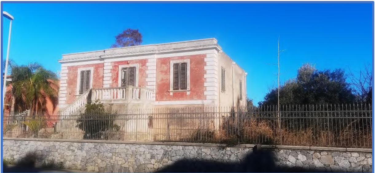
Foto 4 – Prospetto principale, e laterale con esposizione a sud.
