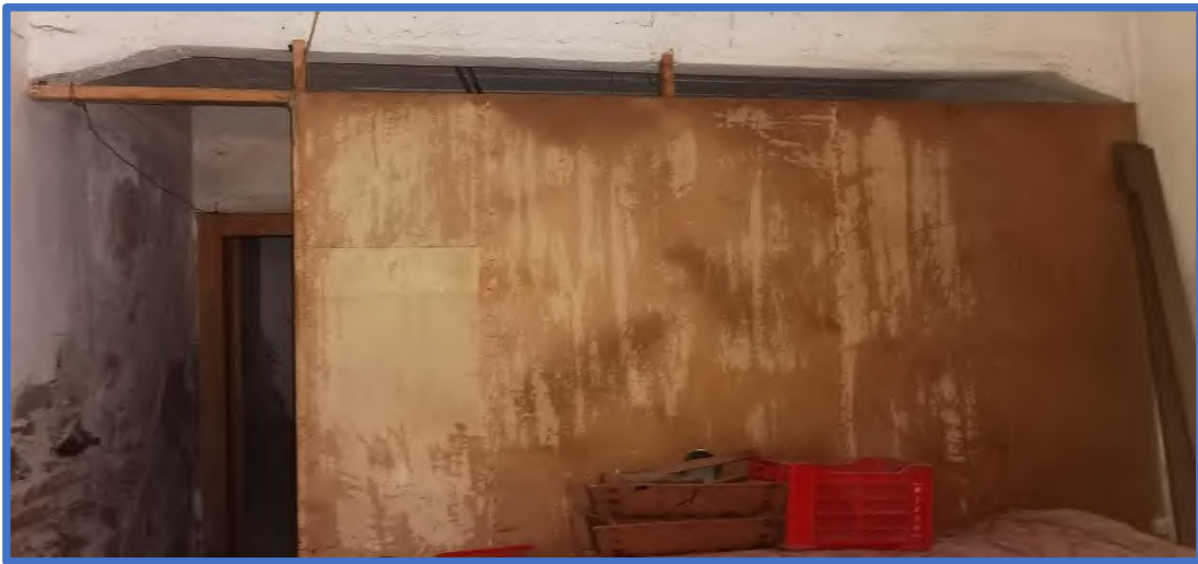
Foto 56 – Pannelli di legno, h. m. 2,10, utilizzati per dividere gli ambienti.
