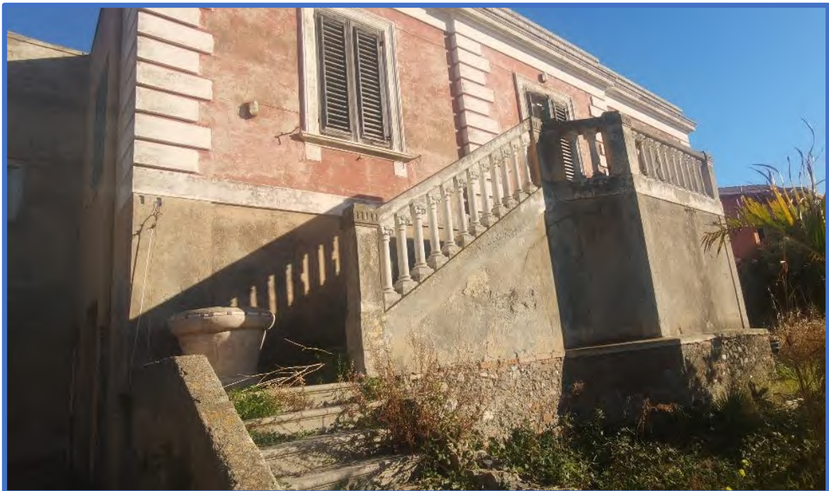
Foto 6– Scala esterna per l'accesso al piano primo.
