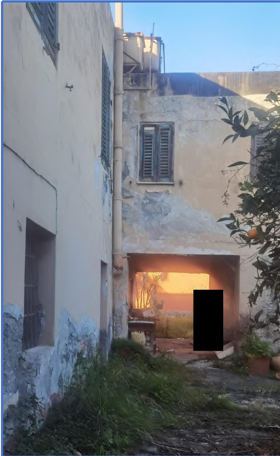
Foto 15 – Vista del portico e del soprastante corpo dei servizi del piano primo.
