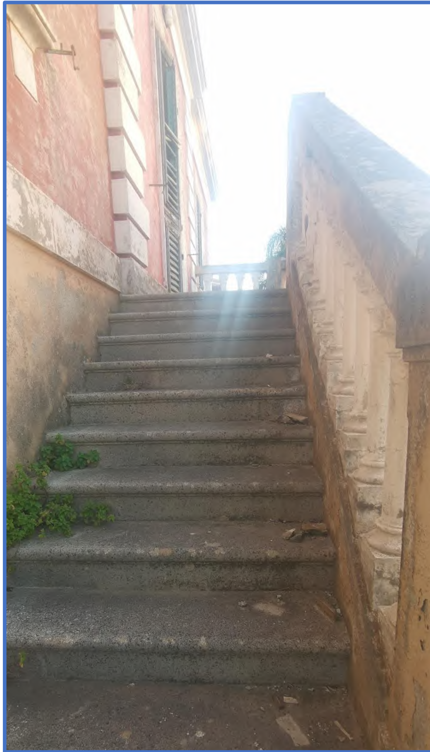
Foto 7 – Scala esterna per l'accesso al piano primo: particolare .
