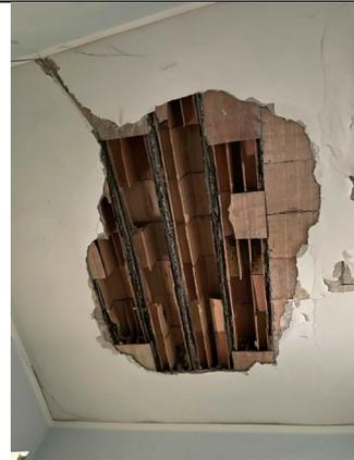
*Sfondellamento solaio bagno piano terra*
