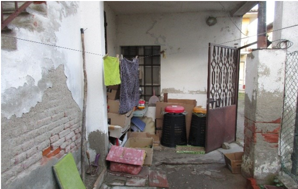
f.5 vista portico con ingresso all'abitazione pignorata (sub 7)
