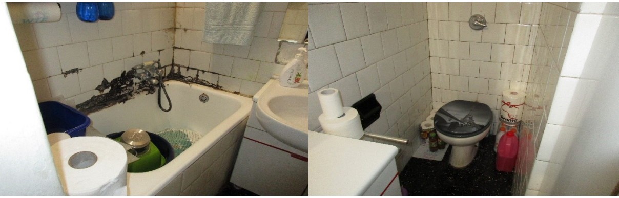
f.11 vista bagno piano terra
