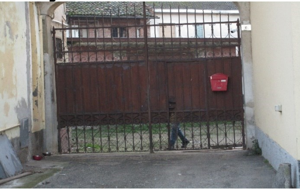
f.2 cancello carroia ingresso cortile comune
