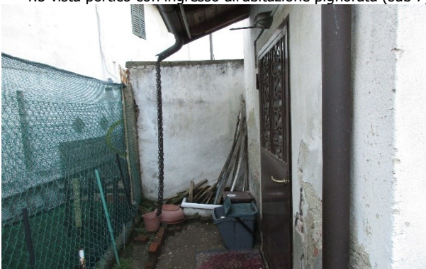
f.7 vista accesso ai locali del piano terra
