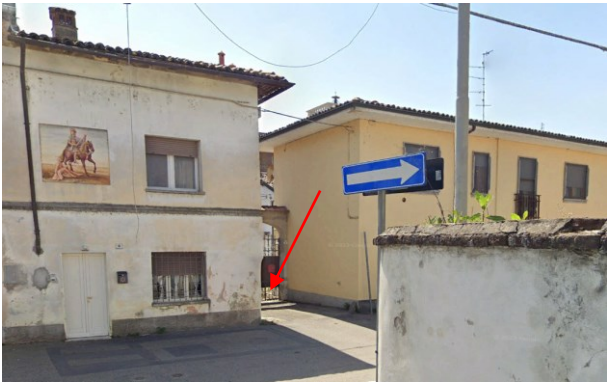
f.1 vista ingresso su via Carso
