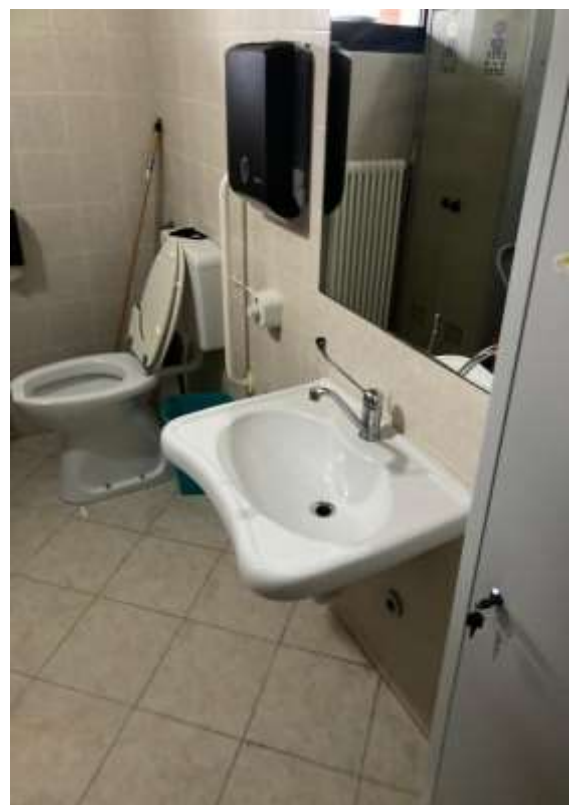
Vista interna 7 bagno privato
