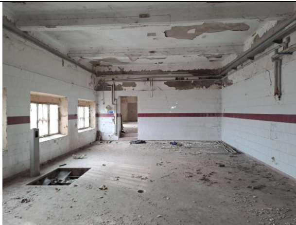
Interno p.t. Fabbricato map.272
