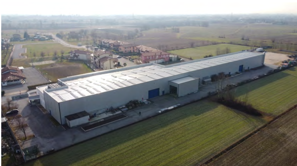
5. Foto: foto stabilimento lato ovest (drone)
