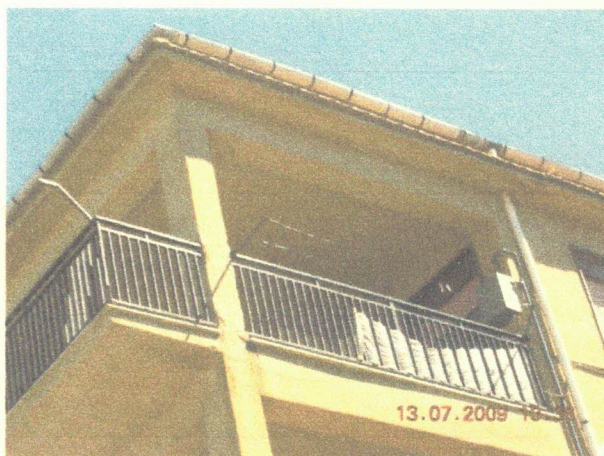
Foto 4 Particolare del terrazzo
