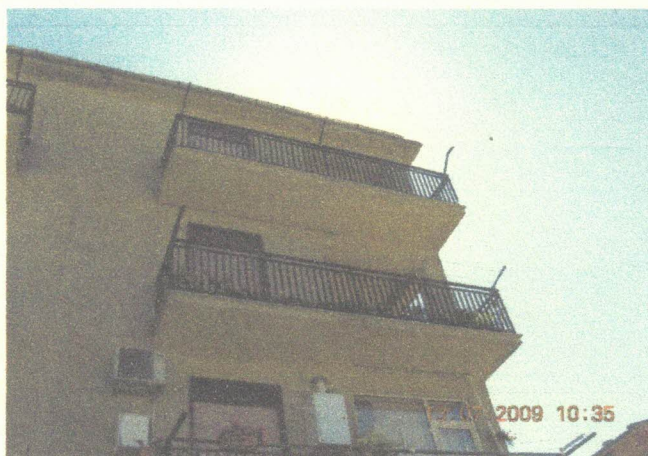
Foto 2 Prospetto angolo tra la Via S. Leone e la Via S. Vincenzo
