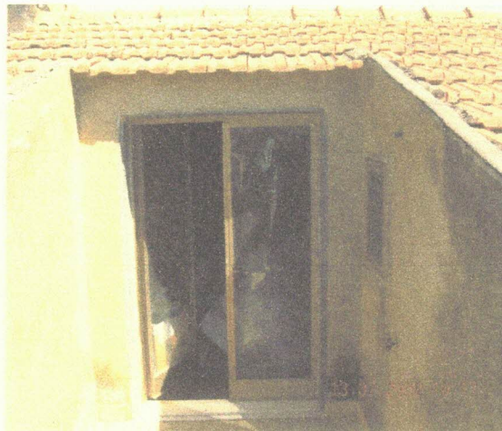
Foto 16 particolare infisso del vano sottotetto
