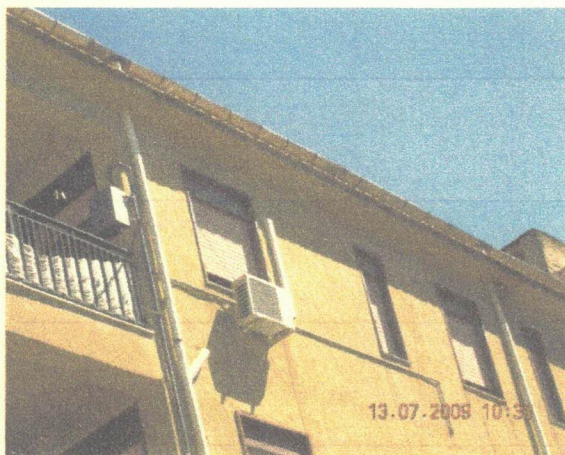
Foto 5 Prospetto sulla Via S. Vincenzo
