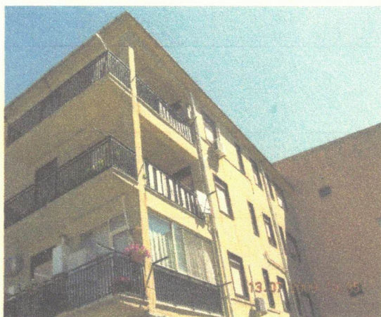
Foto 3 Particolare angolo sud- ovest
