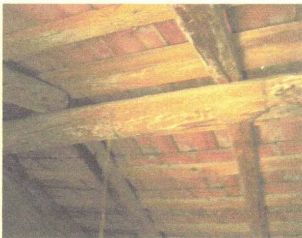
Foto 15 particolare copertura a falde del sottotetto
