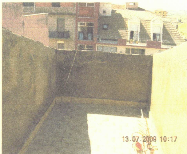
Foto 10 Particolare del terrazzino
