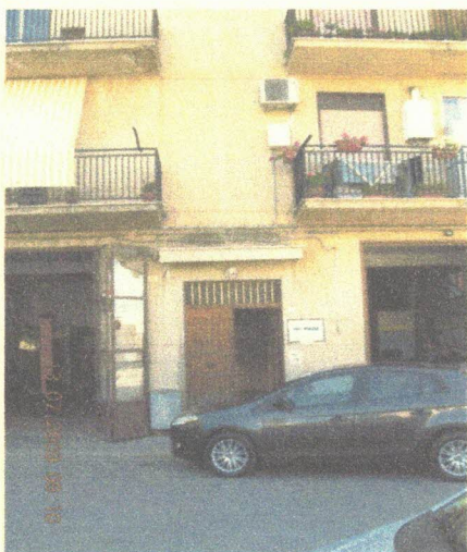
Foto 1 Prospetto ovest su Via Sergio Leone
