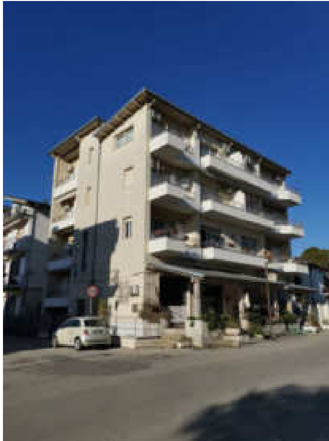
FOTO 1: VISTA PROSPETTO SUD - OVEST
