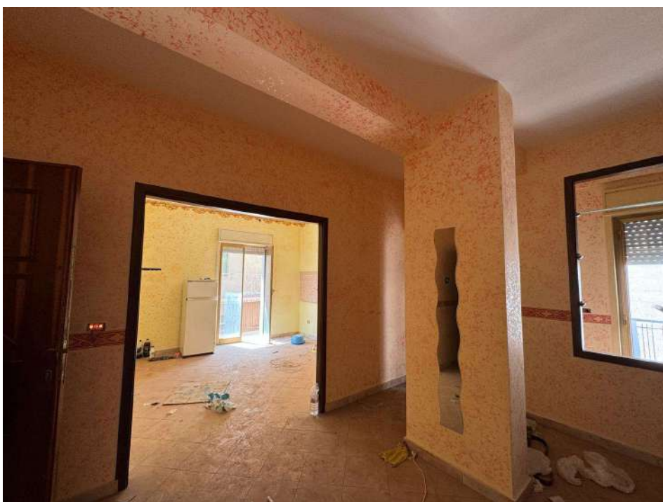
Figura 6: Ingresso con vista su soggiorno e vano finestra su corridoio
