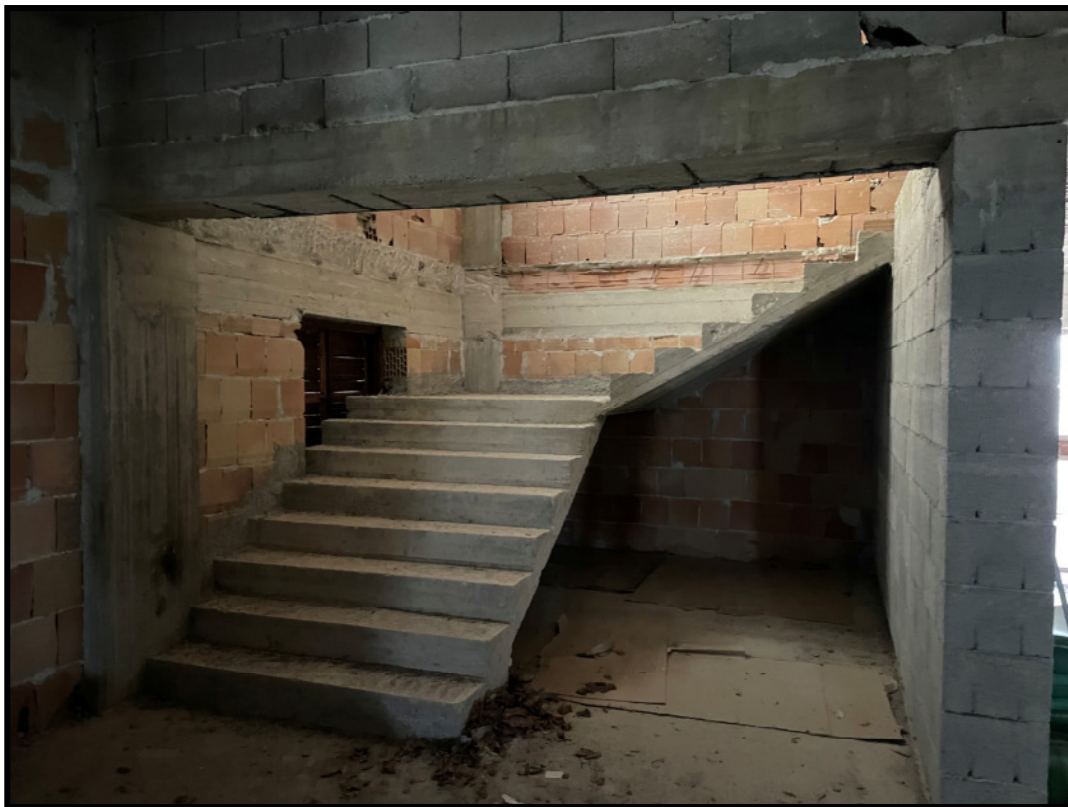
FOTO n°2 – VISTA SCALA da RIMUOVERE
