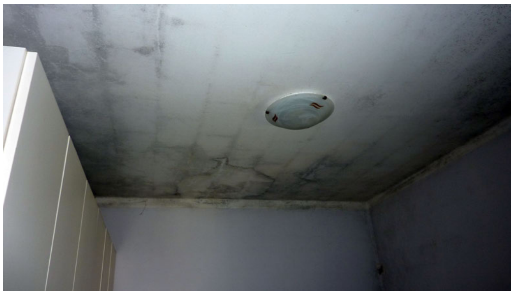
Vista intero ambiente (soffitto camera)
