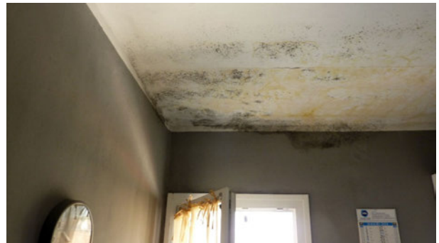
VISTA SOFFITTO CUCINA
