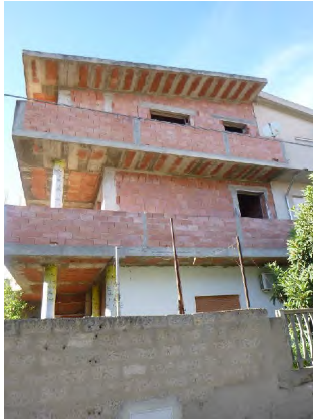
Foto 1.: Prospetto lato Sud
