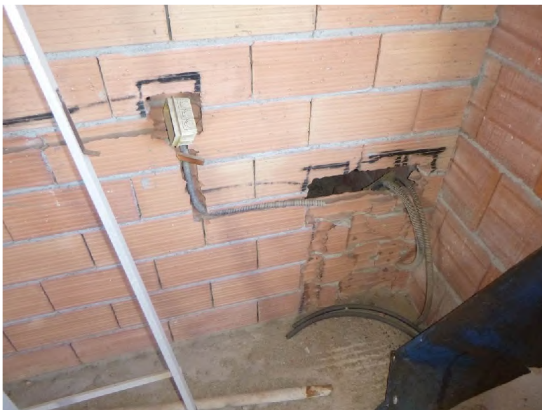
Foto 7.: Posa corrugati per impianto elettrico
