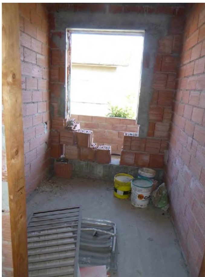
Foto 14.: finestra lato sud
