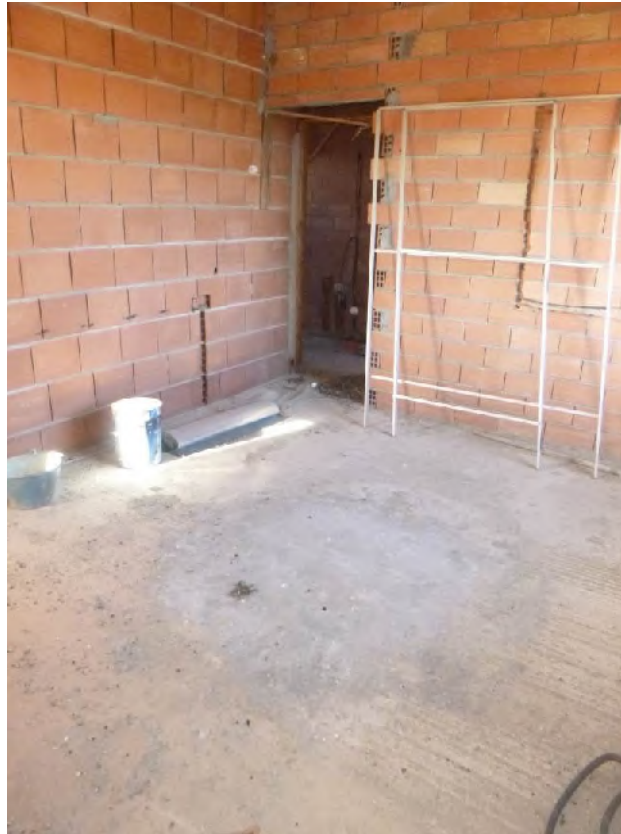
Foto 9.: stato attuale di avanzamento dei lavori piano secondo
