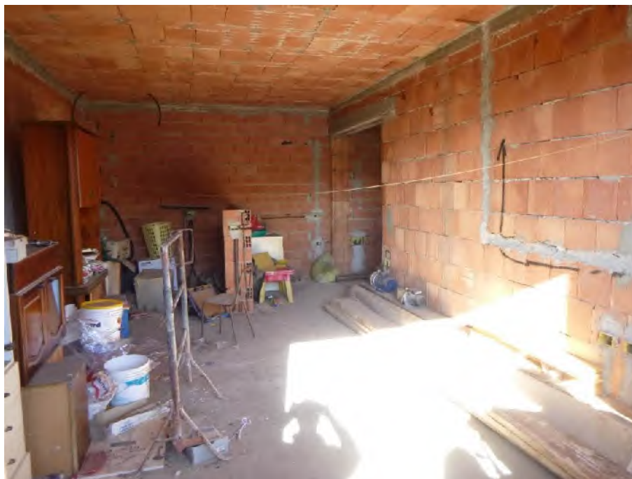
Foto 6.: stato attuale di avanzamento dei lavori piano primo
