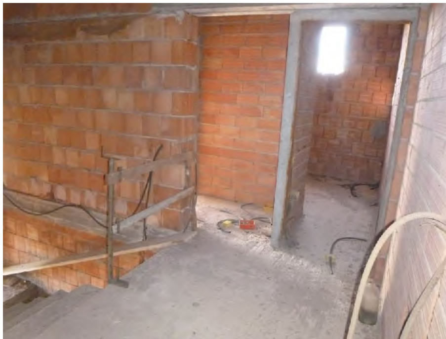
Foto 13.: stato attuale piano secondo
