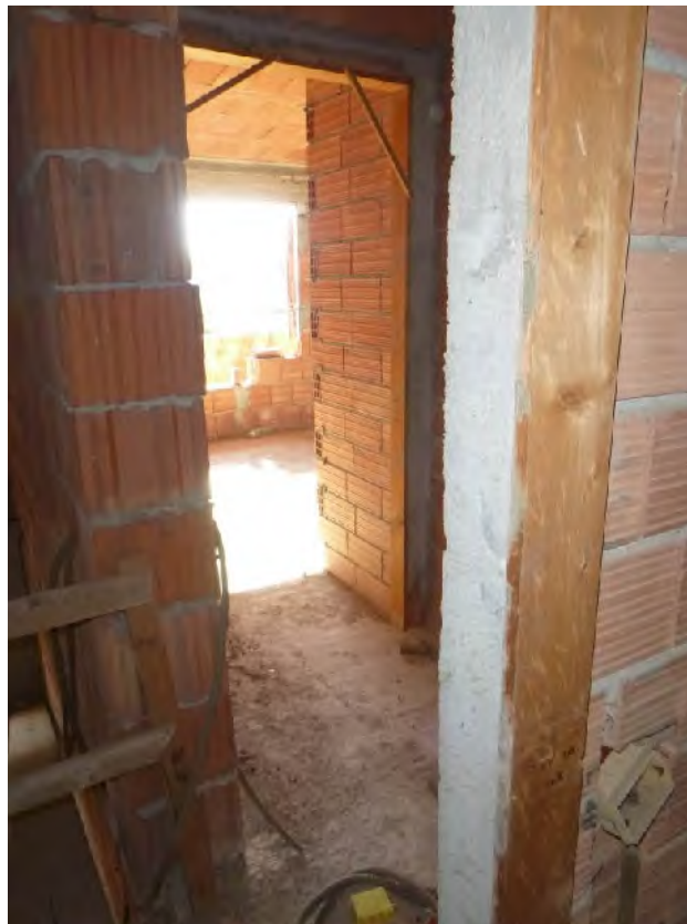
Foto 12.: stato attuale avanzamento lavori piano secondo
