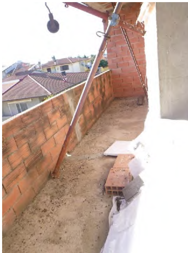
Foto 10.: balcone lato Ovest
