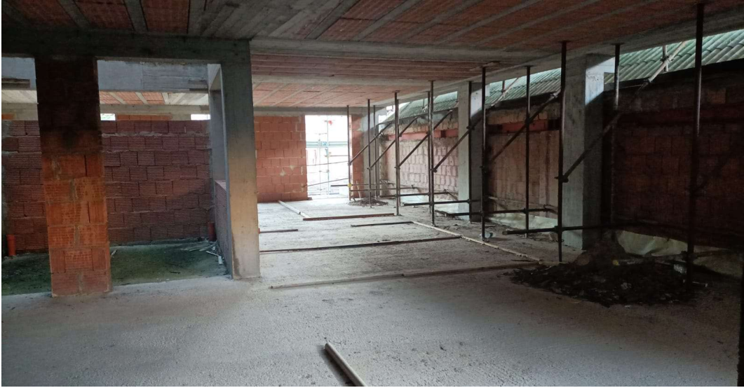
VISTA INTERNA LOTTO N. 2
