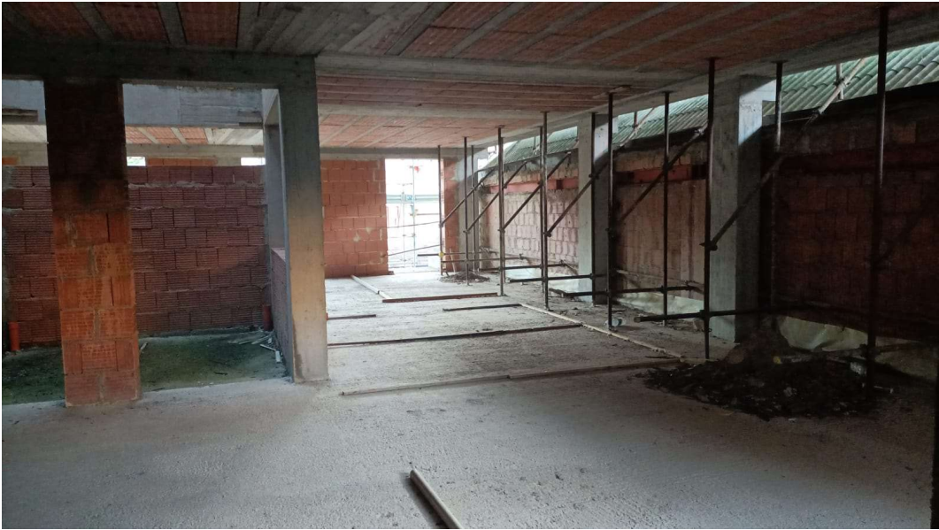
VISTA INTERNA LOTTO N. 6
