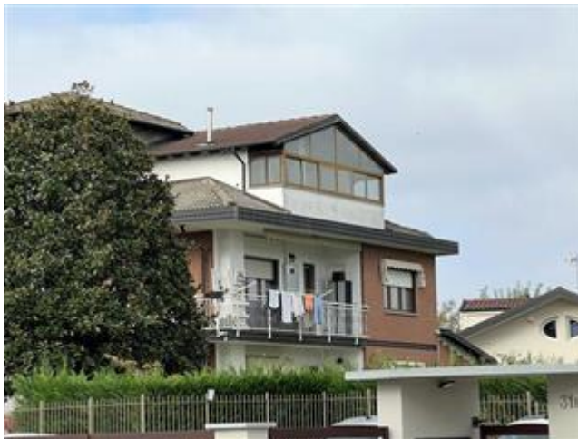
vista della facciata est del fabbricato e del terrazzo chiuso del Lotto 2 al piano secondo
