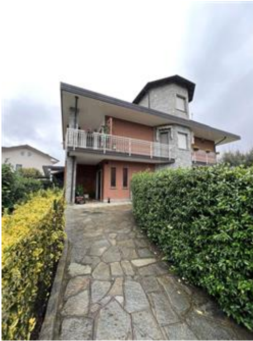
vista dell'esterno del fabbricato e del viale di ingresso, l'area esterna costituente il Lotto 1 è posta sulla sinistra ed è delimitata da siepi poste a ridosso della recinzione a maglie di materiale metallico
