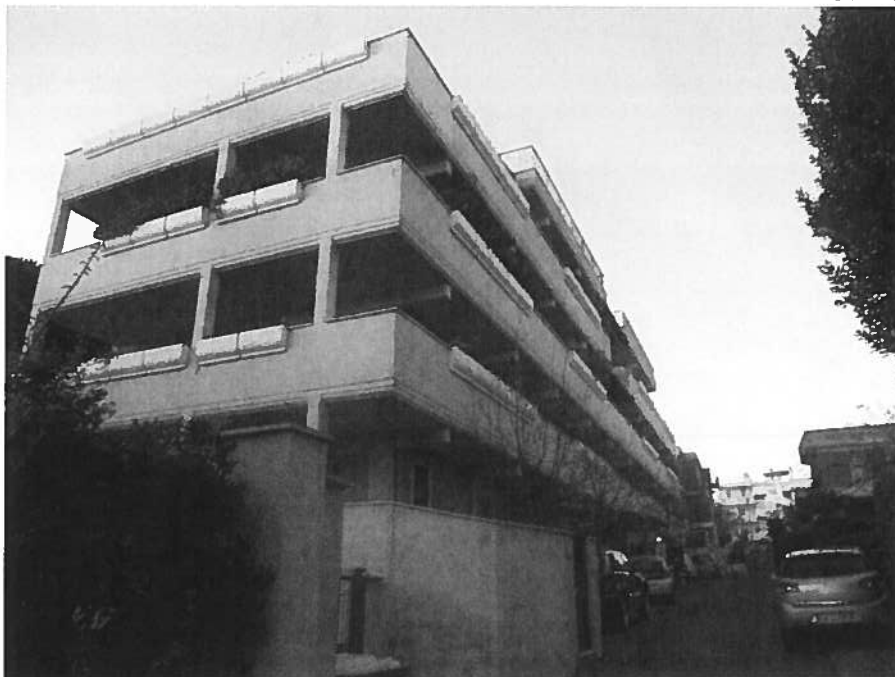
Foto 1 - Il fabbricato in cui insistono i beni visto da Via Brenta
