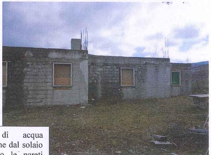
Presenza di acqua meteorica che dal solaio scorre lungo le pareti laterali dell'immobile infiltrandosi all'interno
