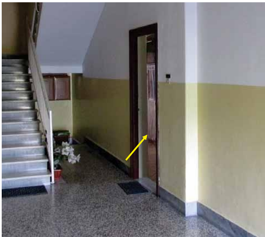
Fotografia 13 – Ingresso: Vi si accede attraverso il portoncino posto a destra di chi entra nell'androne e comunica con il "Corridoio" e con il "Vano 1, occupa una superficie utile netta pari a mq. 3,91 e un'altezza pari a ml. 3,40.
