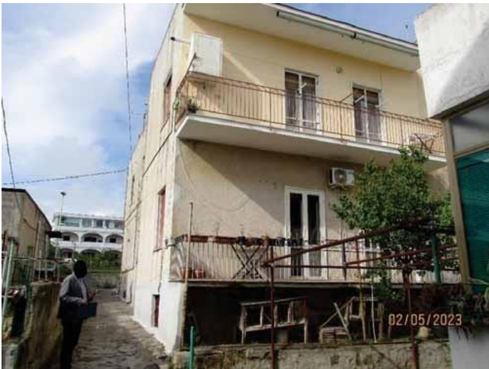
Fotografia 9 –Vista del Fabbricato dall'area comune sul versante sud.
