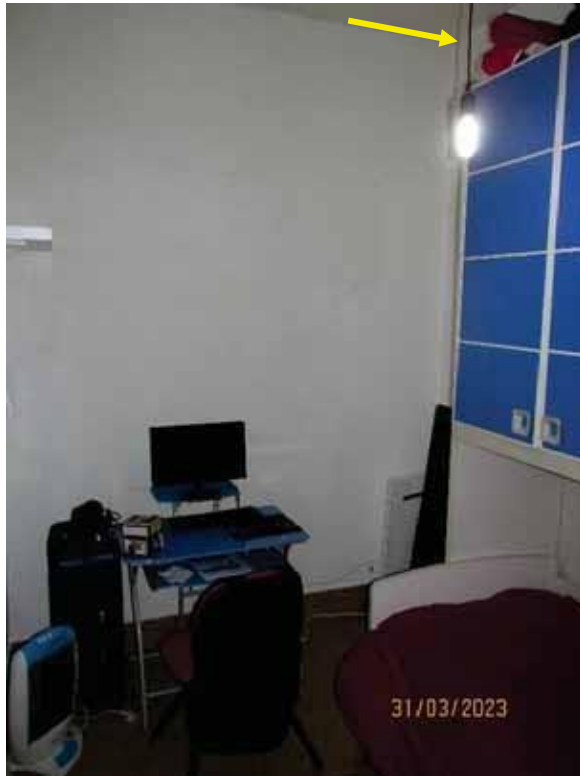
Fotografia 23 – Vano 2: Nella parte alta della parete divisoria con il “Vano 3”, a circa ml. 2,50 dal pavimento è presente un’altra apertura simile a quella precedentemente descritta, anch’essa altezza di circa ml. 0,50, munita di un infisso a vetro singolo non apribile.
