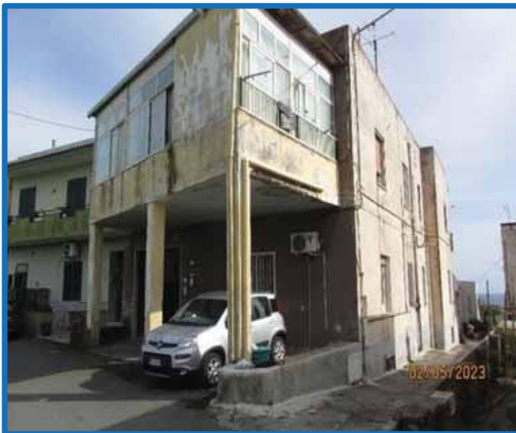
- MONTE DI PROCIDA (NA)- Via Solferino civ. 10
