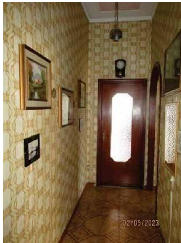
Fotografia 21 – Corridoio: Risulta interamente pavimentato con piastrelle in ceramica smaltata; le pareti sono rivestite con carta da parati, mentre il soffitto risulta rivestito con intonaci ordinari a finitura liscia e tinteggiato con pittura a tempera.
