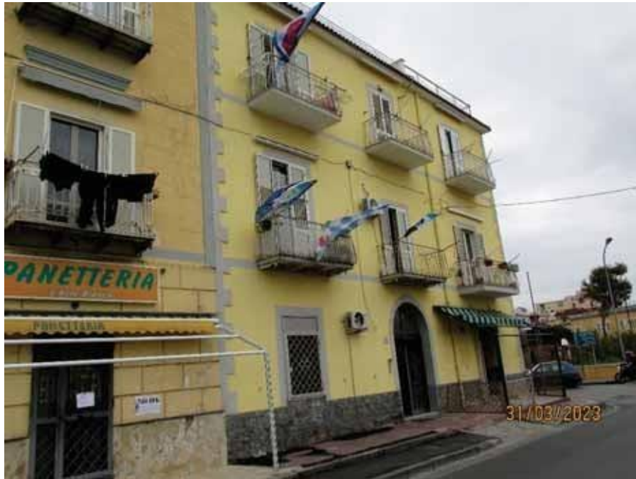
Fotografia 7 – Altra vista del Fabbricato da Via Lungolago.
