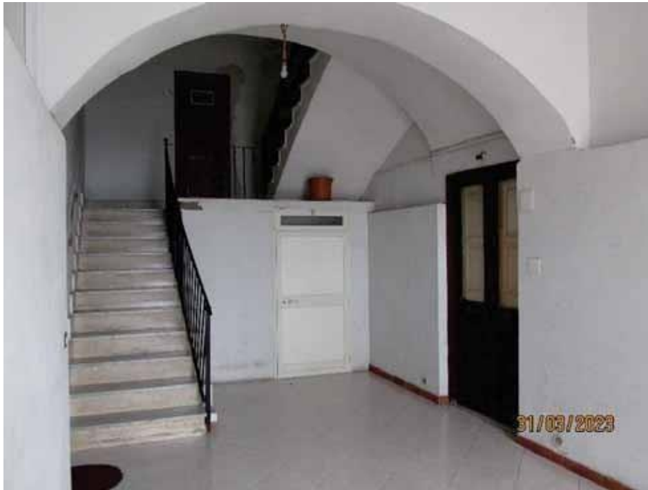
Fotografia 13 –La scala condominiale conduce ai piani superiori, è costituita da rampanti intervallati da ballatoi protetti da una ringhiera in ferro. I rampanti presentano le pedate e le alzate rivestite da lastre in marmo.
