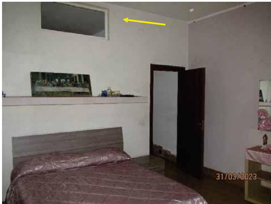
Fotografia 27 – Vano 3 nella parte alta della parete divisoria con il “Vano 2”, a circa ml. 2,50 dal pavimento è presente un’apertura avente altezza di circa ml. 0,50, munita di un infisso a vetro singolo non apribile.
