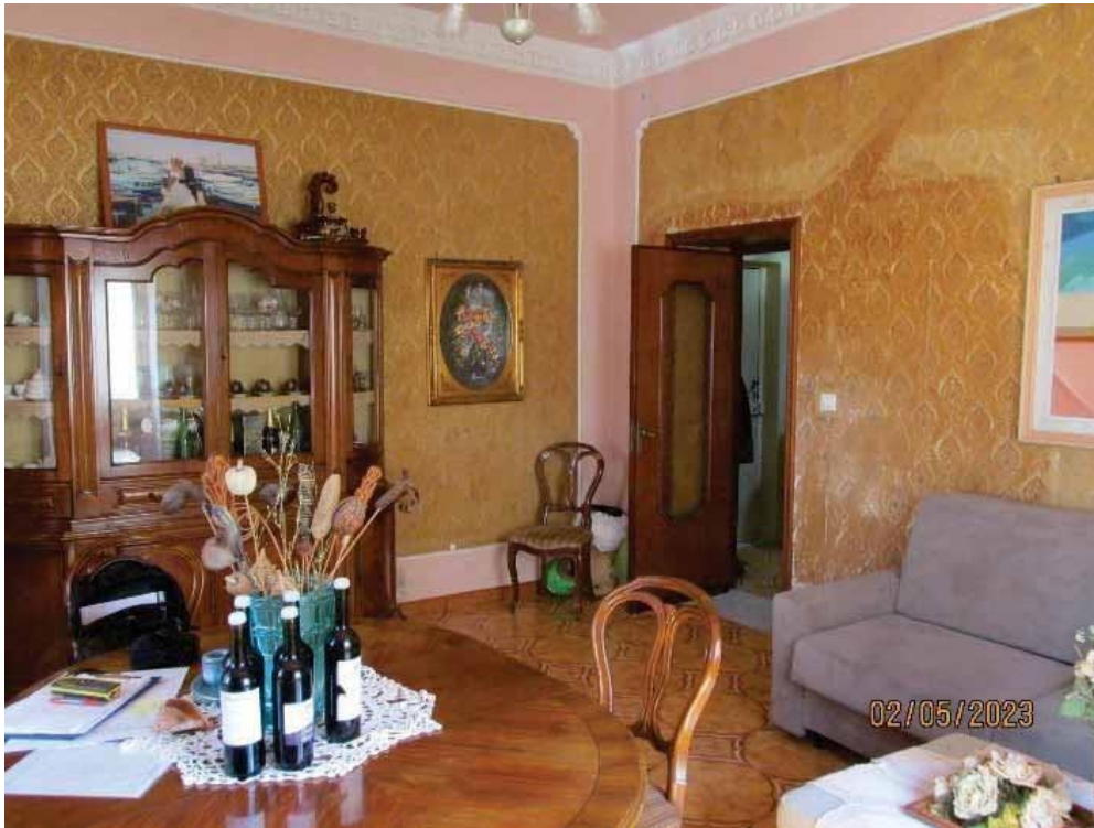
Fotografia 17 – Vano 1: Risulta adibito come Soggiorno ed è pavimentato con piastrelle in ceramica smaltata; presenta le pareti rivestite con intonaci ordinari a finitura liscia, decorate con carta da parati e listelli in gesso; il soffitto è rivestito con intonaci ordinari a finitura liscia e tinteggiato con pittura a tempera.
