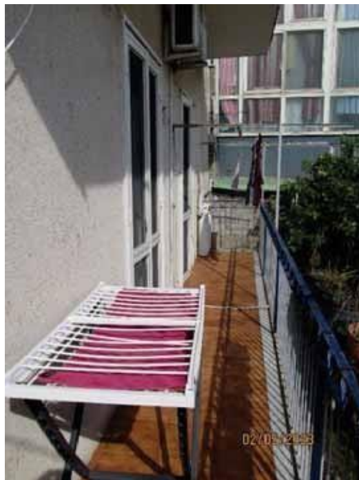
Fotografia 38 – Balconata: Vi si accede dal “Vano 2” e dal “Vano 3”, occupa una superficie utile netta pari a mq. 8,91. Risulta esposta a sud con affaccio sull'area in comune all'appartamento del piano primo.
