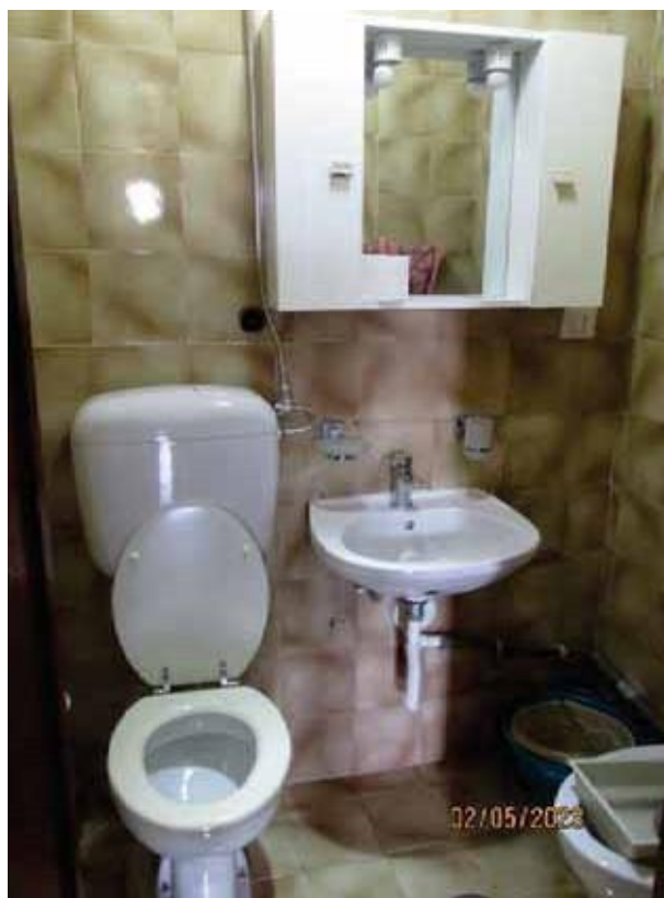
Fotografia 33 – Bagno 2: Vi si accede dal “Disimpegno”, occupa una superficie utile netta pari a mq. 1,70 e un'altezza pari a ml. 3,40. L'ambiente è dotato di tazza igienica, lavabo e bidet. Presenta il pavimento e le pareti interamente rivestiti con piastrelle in ceramica smaltata; il soffitto risulta interamente rivestito con intonaci ordinari a finitura liscia e tinteggiato con pittura a tempera.
