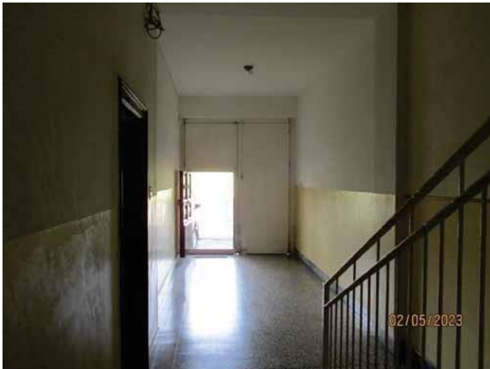
Fotografia 11 – L’androne condominiale risulta interamente pavimentato in graniglia di marmo levigato; presenta le pareti interamente rivestite da intonaci ordinari e tinteggiate con pittura lavabile, il soffitto è interamente intonacato e risulta tinteggiato con pittura a tempera.
