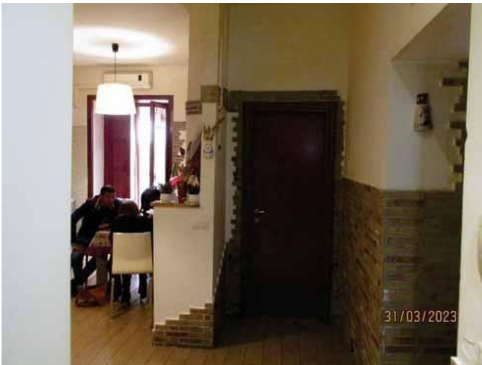
Fotografia 16 – Corridoio: Risulta pavimentato con piastrelle in gres porcellanato, le pareti sono intonacate e tinteggiate con pittura lavabile ad eccezione della parte inferiore che risultano rivestite con un “lambris” formato da mattoncini rossi. Il soffitto è interamente rivestito con intonaci ordinari a finitura liscia e tinteggiato con pittura a tempera.
