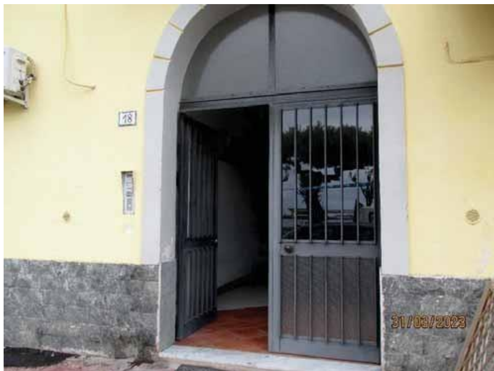
Fotografia 10 – Vista del varco pedonale protetto esternamente da un cancello in ferro a due ante, munito di impianto citofonico collegato agli appartamenti.
