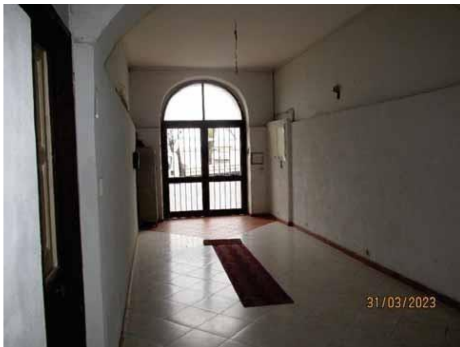
Fotografia 12 –L'androne presenta le pareti rivestite da intonaci ordinari e tinteggiate con pittura lavabile, il soffitto è intonacato e tinteggiato con pittura a tempera.
