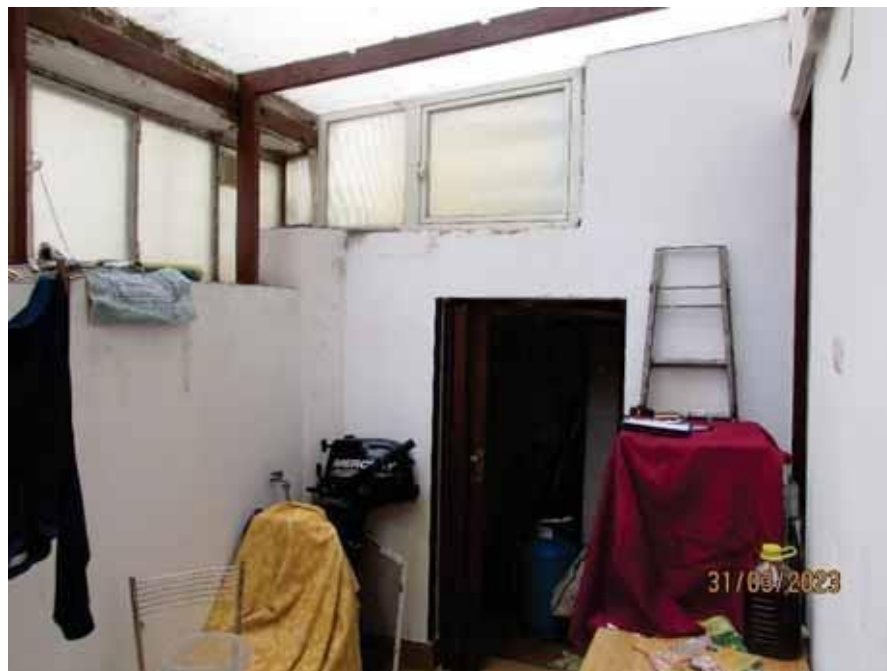
Fotografia 36 – Corte esclusiva: la parte terminale della parete perimetrale esterna, dispone di una struttura in ferro che lungo tutto il perimetro costituisce una chiusura d'ambito composta da finestroni in ferro con pannelli in plexiglass alveolari trasparenti opachi; anche l'intera copertura della corte è costituita da una tettoia composta da una struttura in ferro su cui sono poggiate delle lastre in plexiglass trasparente opache.
