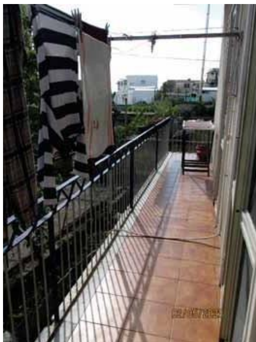
Fotografia 39 – Balconata : La pavimentazione è costituita da piastrelle in ceramica smaltata e risulta protetto verso l'esterno da una ringhiera in ferro.
