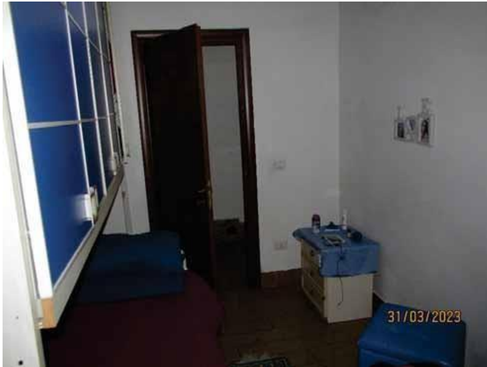
Fotografia 21 – Vano 2: L'ambiente è adibito a cameretta, è interamente pavimentato con piastrelle in gres porcellanato, presenta le pareti intonacate e tinteggiate con pittura lavabile; il soffitto risulta rivestito con intonaci ordinari a finitura liscia e tinteggiato con pittura a tempera.
