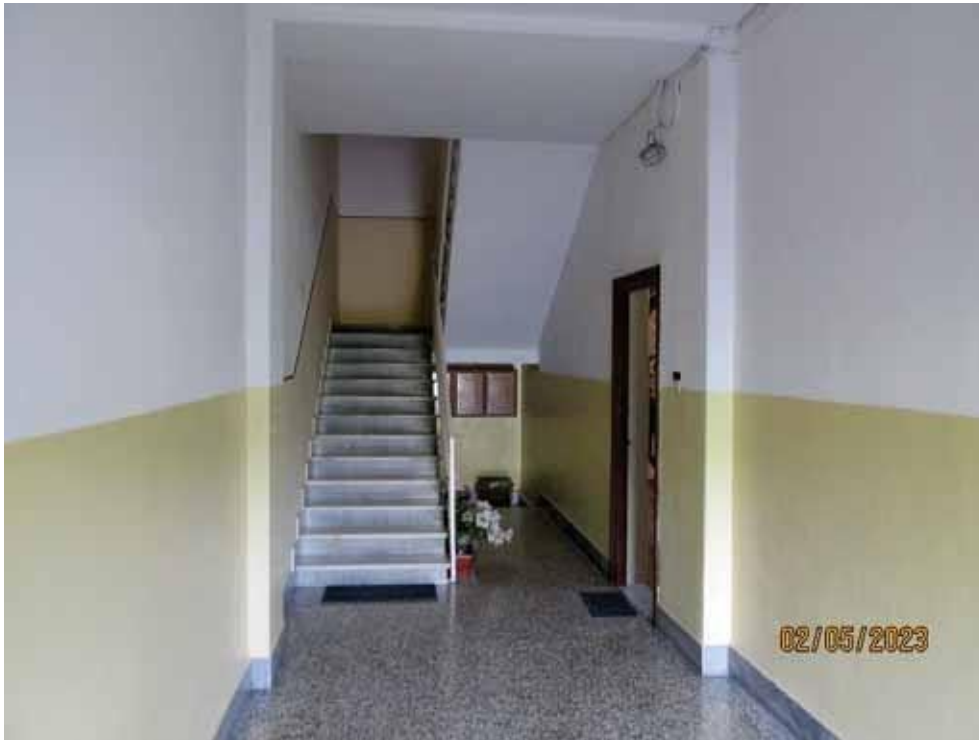
Fotografia 12 – La scala condominiale, è costituita da rampanti intervallati da ballatoi protetti da una ringhiera in ferro. I rampanti presentano le pedate e le alzate rivestite da lastre in marmo.
