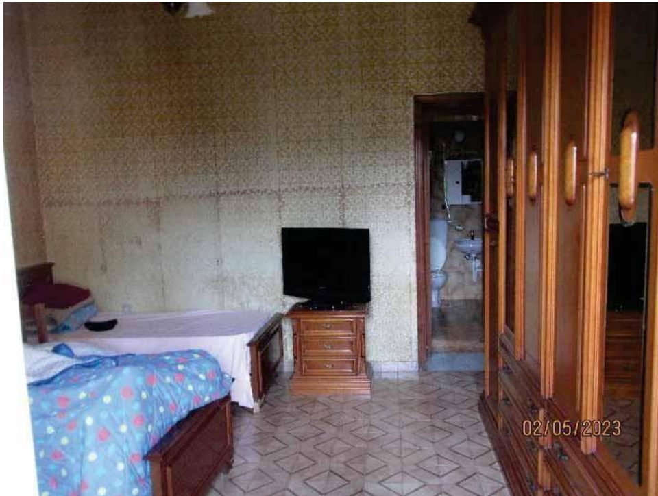
Fotografia 28 – Vano 2: le pareti rivestite con intonaci ordinari a finitura liscia e decorate con carta da parati; il soffitto è rivestito con intonaci ordinari a finitura liscia e tinteggiato con pittura a tempera.
