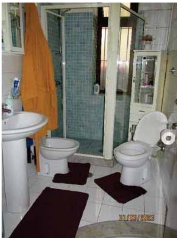
Fotografia 32 – Bagno : La superficie dell’ambiente è rialzata rispetto al resto dell’appartamento di circa 10 cm., all’ingresso vi è un gradino che si sviluppa lungo l’arco di apertura della porta; la pavimentazione è costituita da piastrelle in ceramica smaltata mentre le pareti sono rivestite anch’esse con piastrelle in ceramica smaltata per un’altezza di circa ml. 2,10 dal pavimento, mentre la restante parte sono intonacate e tinteggiate con pittura lavabile.
