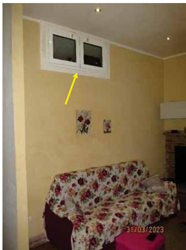
Fotografia 19 – Vano 1: Nella parte alta della parete divisoria tra il “Vano 1” e il “Vano 2”, precisamente a circa ml. 2,50 dal pavimento è installata una finestra avente altezza di circa ml. 0,50 apribile dal “Vano 2” in modo da consentire l'aerazione di quest'ultimo vano.
