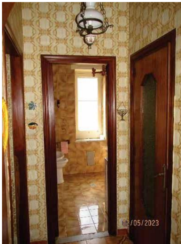
Fotografia 26 – Disimpegno: L’ambiente è pavimentato con piastrelle in ceramica smaltata; presenta le pareti interamente rivestite con carta da parati; il soffitto è rivestito con intonaci ordinari a finitura liscia e tinteggiato con pittura a tempera.
