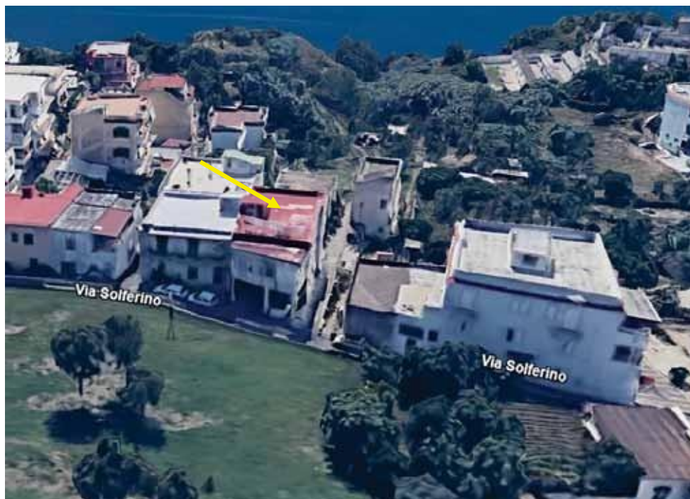
Fotografia 2 – Inquadramento territoriale lato Nord.
