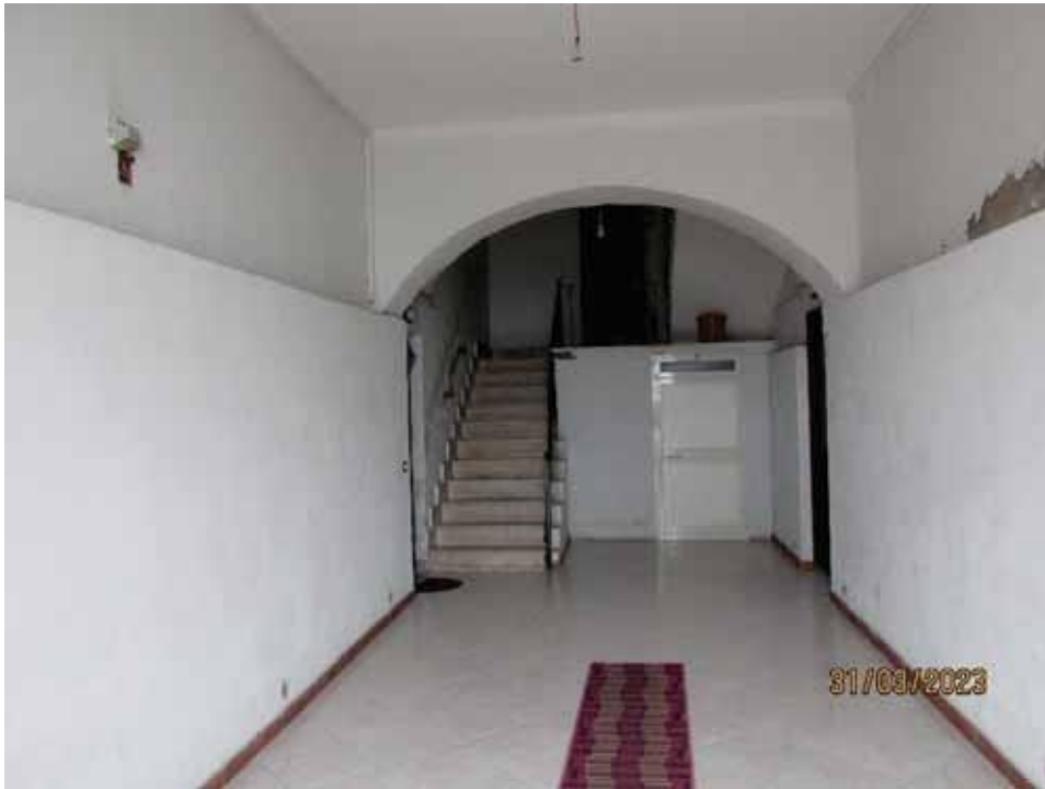
Fotografia 11 – L'androne condominiale risulta interamente pavimentato con piastrelle in ceramica smaltata.
