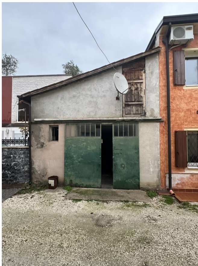
Foto n. 9 – Rustico – Vista esterna – P.T.
