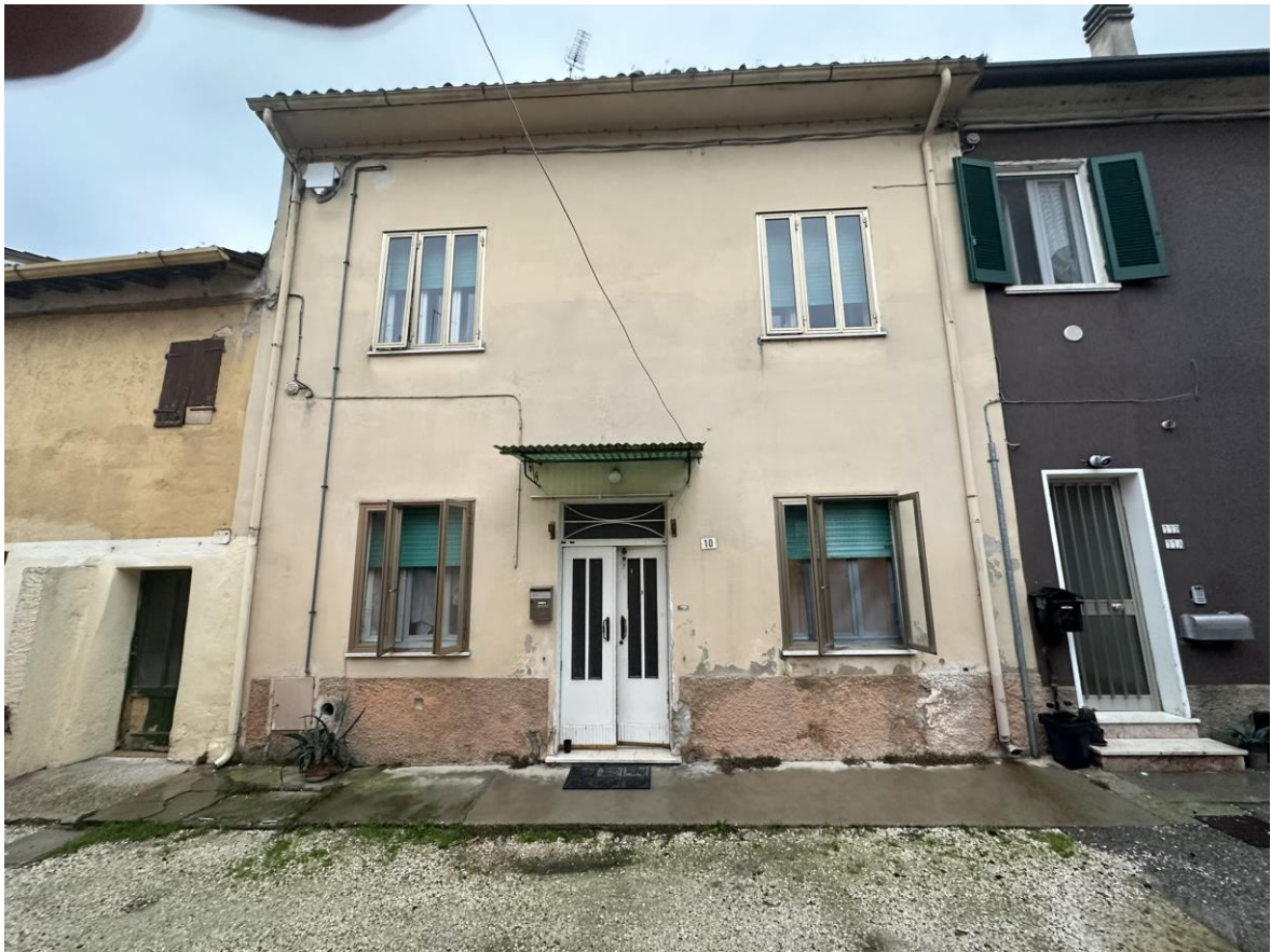
Foto n. 1 – Abitazione – Vista esterna – P.T.
