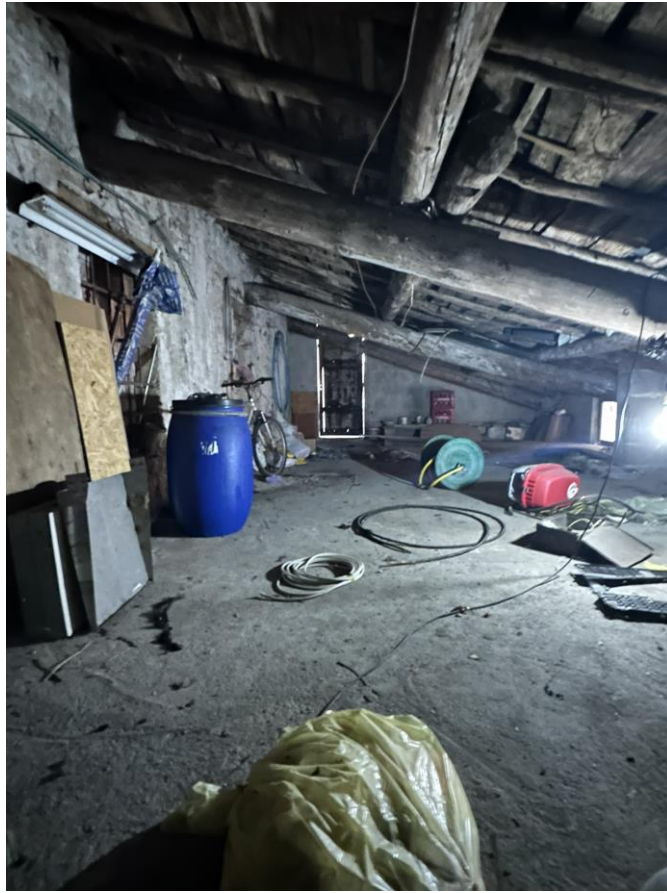
Foto n. 12 – Rustico – Soffitta – P. II°.
