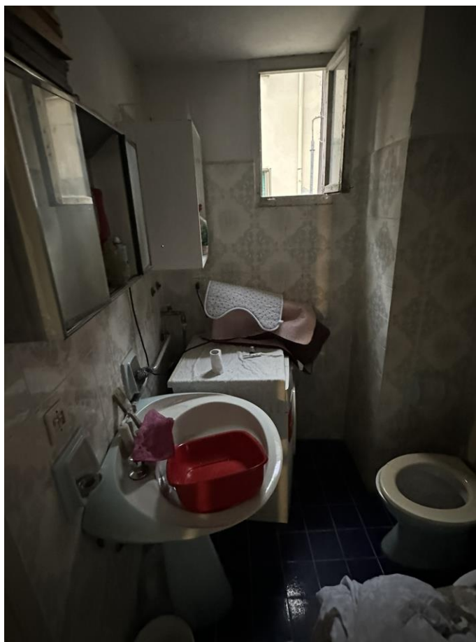
Foto n. 11 – Rustico – Bagno – P.T.
