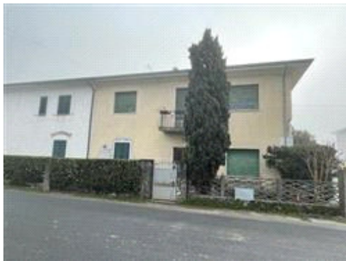
Fronte su via del Paduletto
