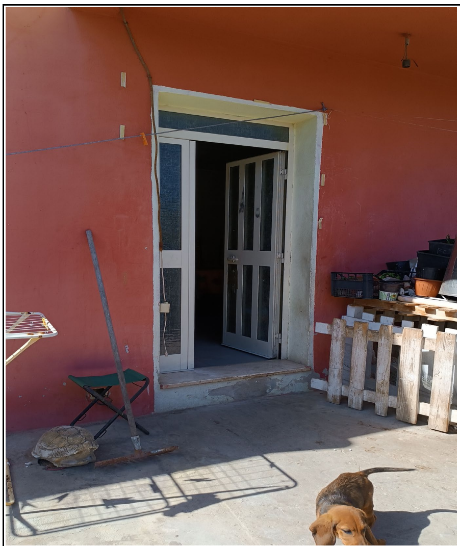
Foto n°7 - Piano terra: porta d'ingresso
