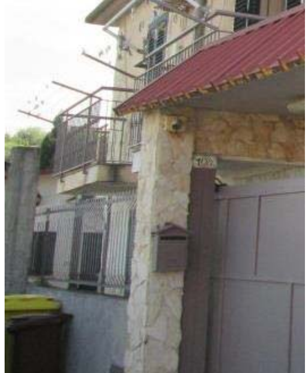
FOTO 8 – Scordia – Via Moravia,10 – Fabbricato secondario - deposito – piano terra – p. 1223 sub. 2
