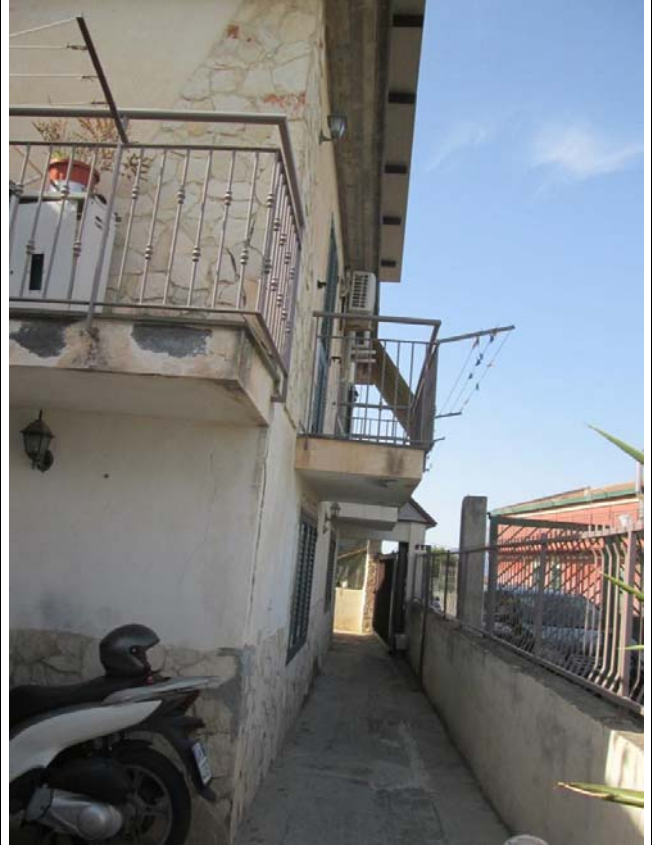
FOTO 2 – Scordia – Via Moravia,10 – Fabbricato principale – piano terra – p. 1223 sub. 1
