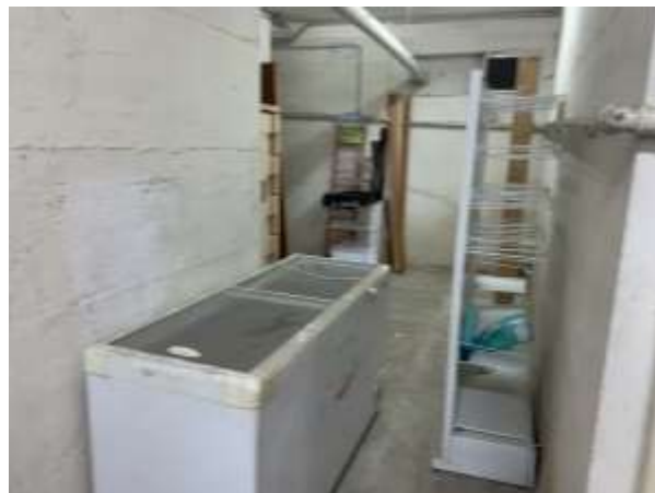
Foto 3 e 4 Particolare delle pareti in cls, pavimento in battuto di cemento, impianto elettrico a vista e tubazioni del piano terra
