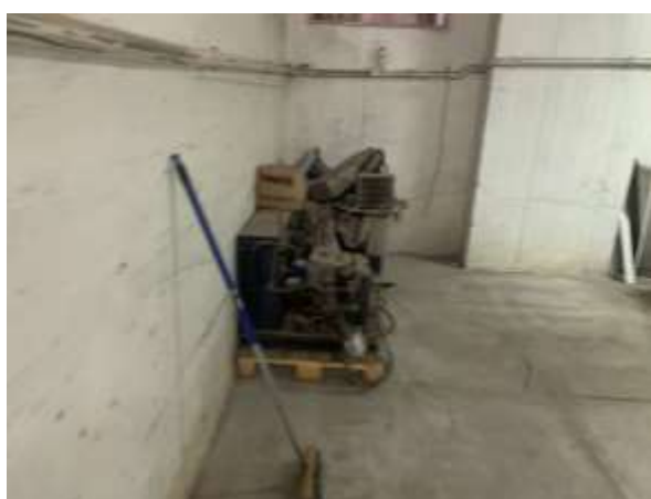
Foto 3 e 4 Particolare delle pareti in cls, pavimento in battuto di cemento, impianto elettrico a vista e tubazioni del piano terra
