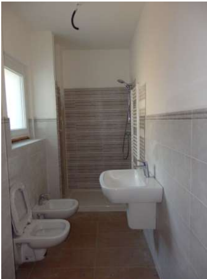
Appartamento al piano terra censito al C.F. fg.37 mapp.225 sub.4-12. Finiture bagno. Particolare termoarredo allacciato alle tubazioni.
