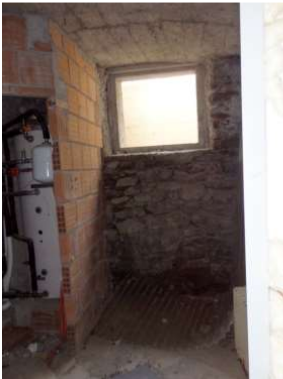
Piano interrato, disimpegno cantina Colonne impianto di riscaldamento e acqua calda.
