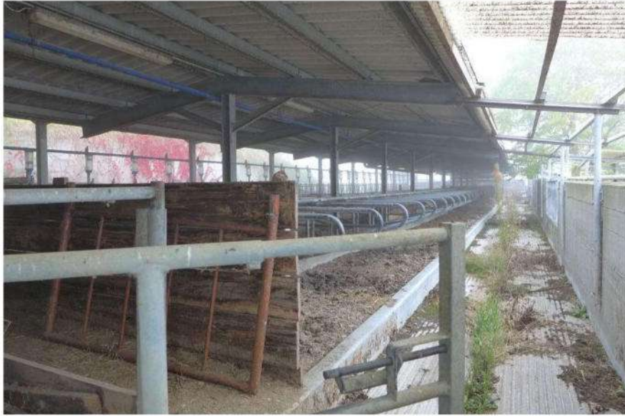
Figura 9: viste interne fabbricato C – stalla, sala mungitura e sala latte.
