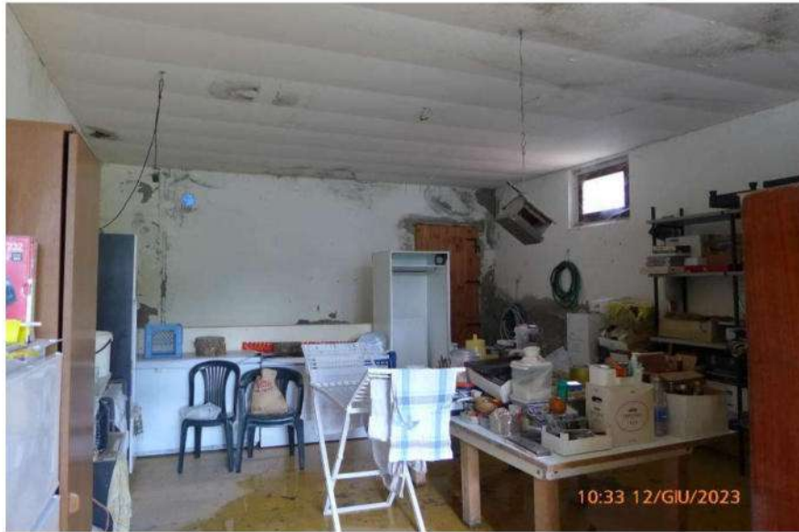
Figura 8: viste interne fabbricato B – abitazione.
