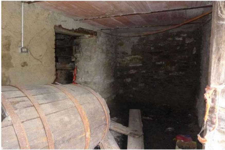
Figura 10: viste interne fabbricato D – abitazione in disuso piano seminterrato.
