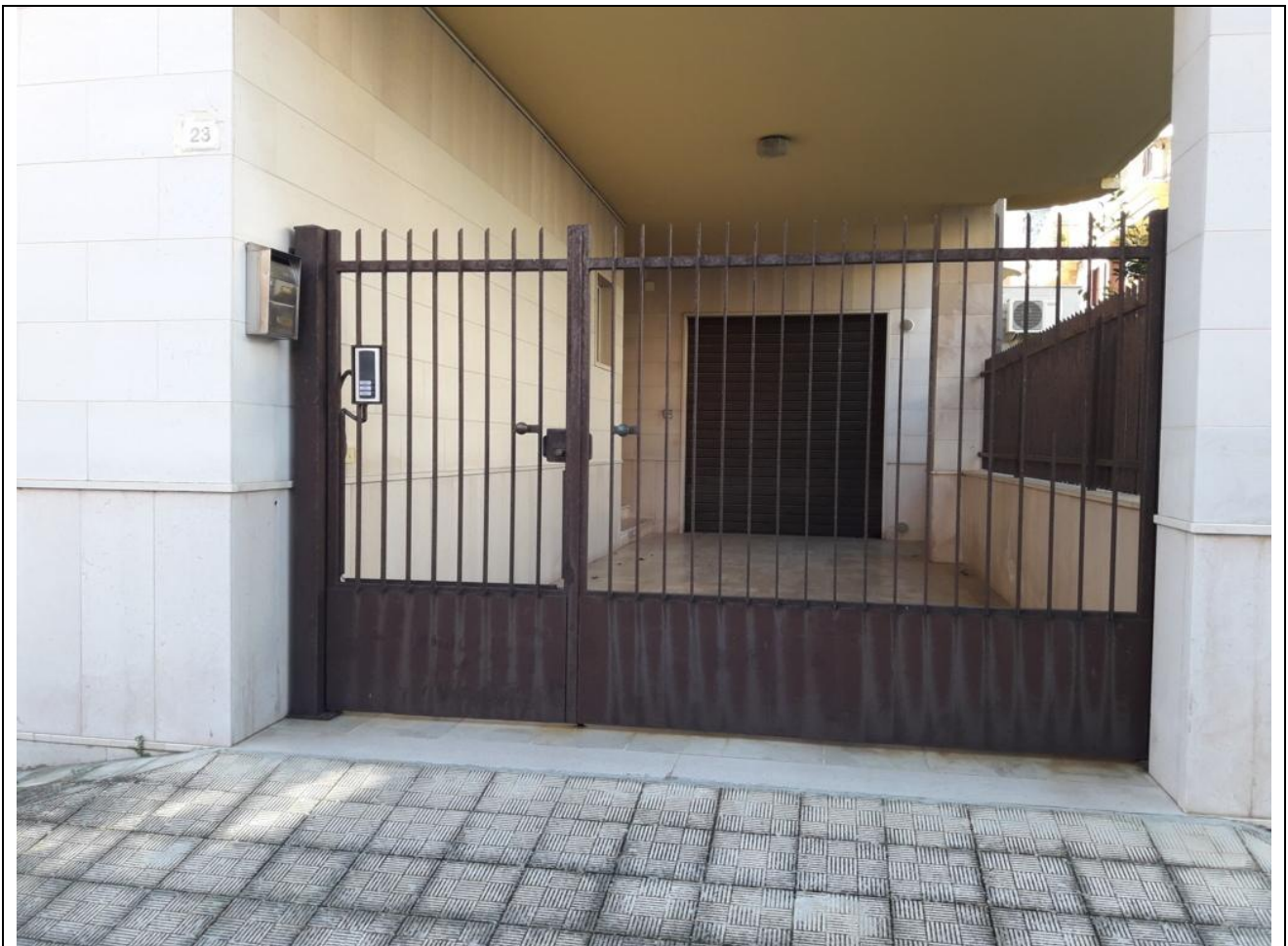
1 – Cancellone d'ingresso allo stabile sito in Lesina (FG) alla traversa corso Umberto I civico 23
