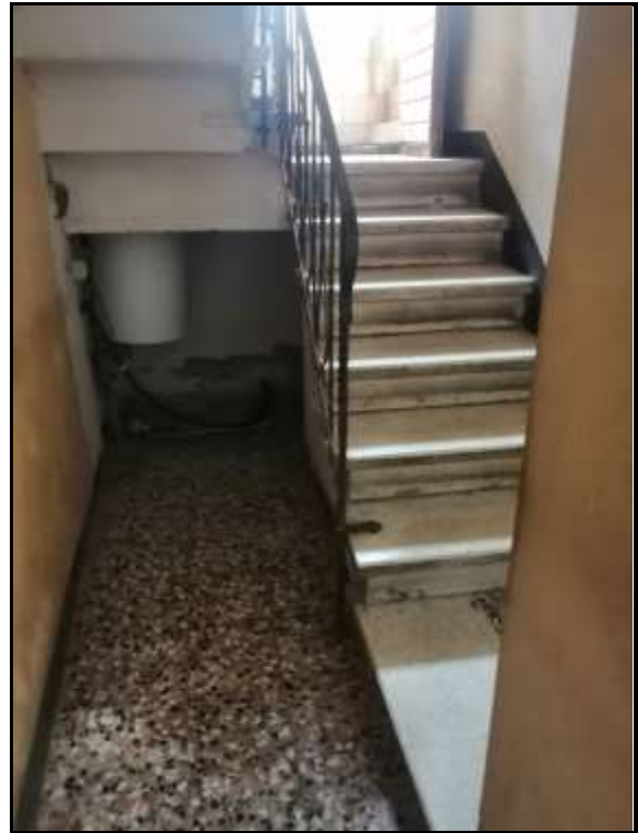
Foto 6 – vano scala PT/P1
