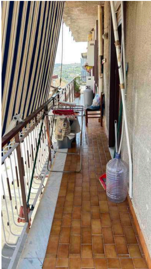
fig.10 – P. 2 balcone su via Arezzo
