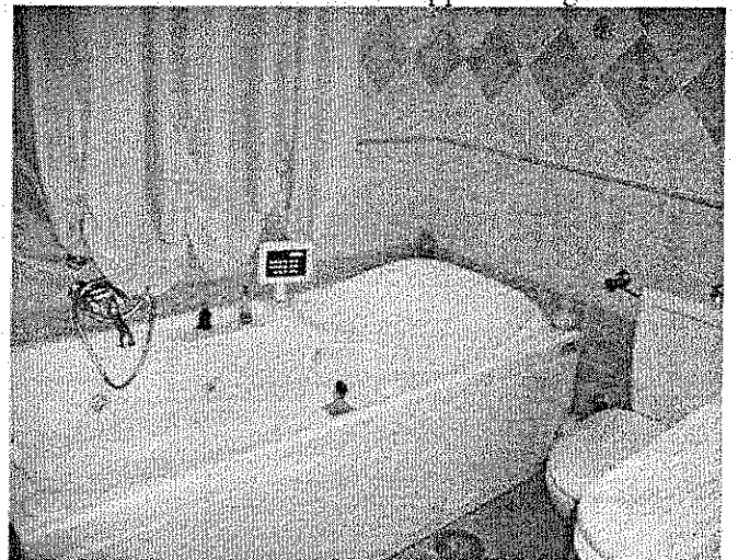
Foto n. 35 e 36 -Particolare di un Bagno al P.1°.
