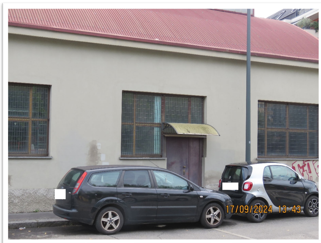
Porzione del fabbricato "E" in cui si trova la porzione di capannone in esame – estremità Est del complesso condominiale – e particolare dell'ingresso diretto dalla strada.
