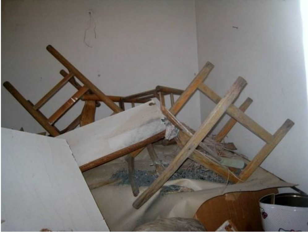
Foto n. 20. L'interno del vano lavanderia.
