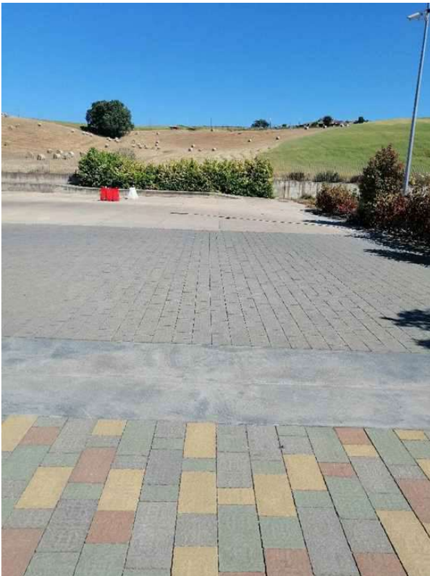
Fotografia 11 – Area esterna pertinenziale
