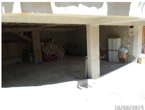
Foto 1: Piano seminterrato porzione area parcheggio
