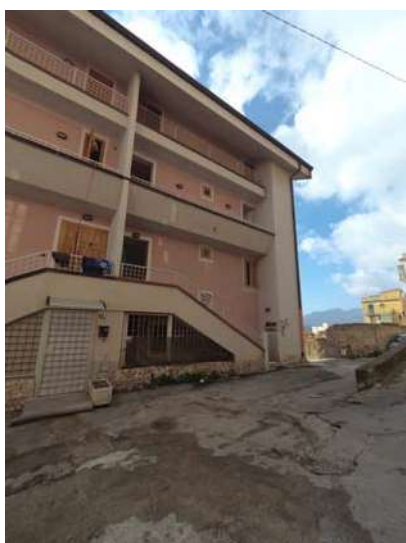
Figura 2: Vista fabbricato da via Salita Sant'Antonino
