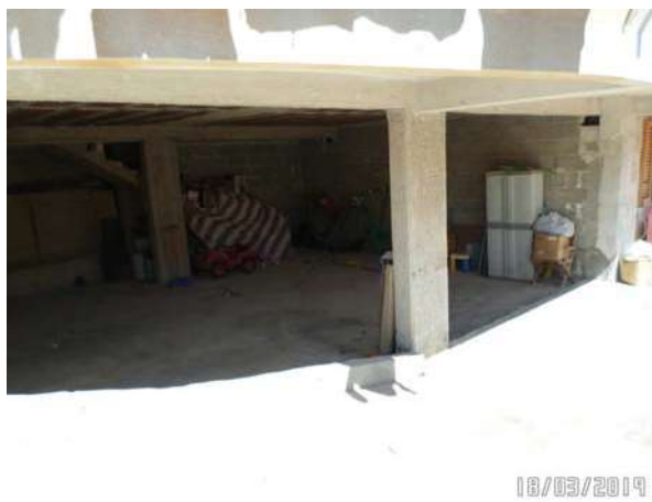
Foto 1: Piano seminterrato porzione area parcheggio
