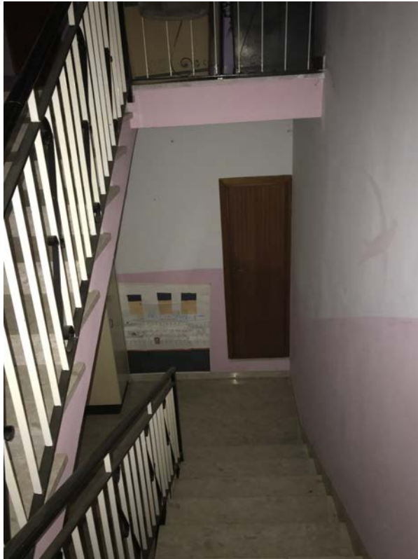
Figura 4: Scala interna e ripostiglio piano 1
