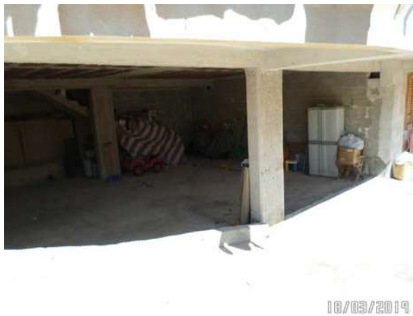
Foto 1: Piano seminterrato porzione area parcheggio
