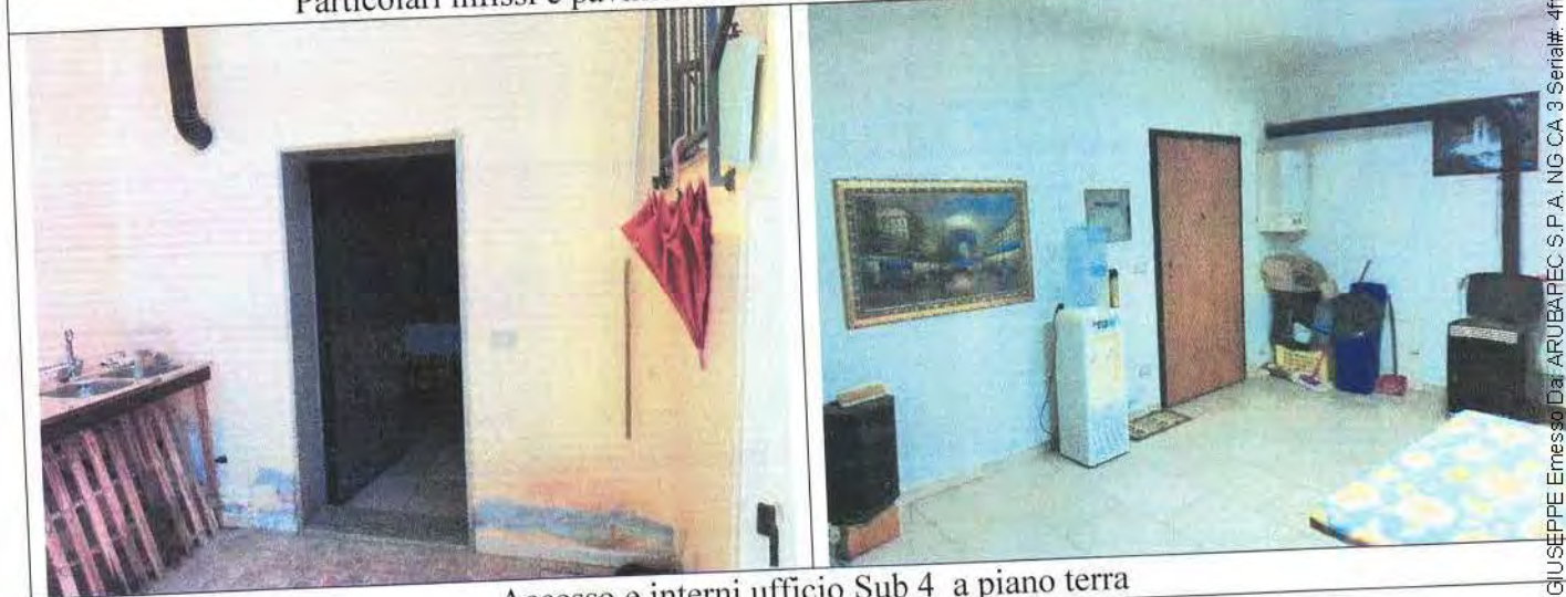
Particolari infissi e pavimentazione ufficio annessi a piano terra Sub 4
