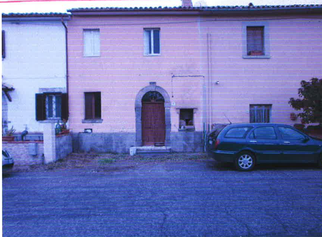
foto n.1 vista dalla strada provinciale 5 - Loc. S. Sebastiano
