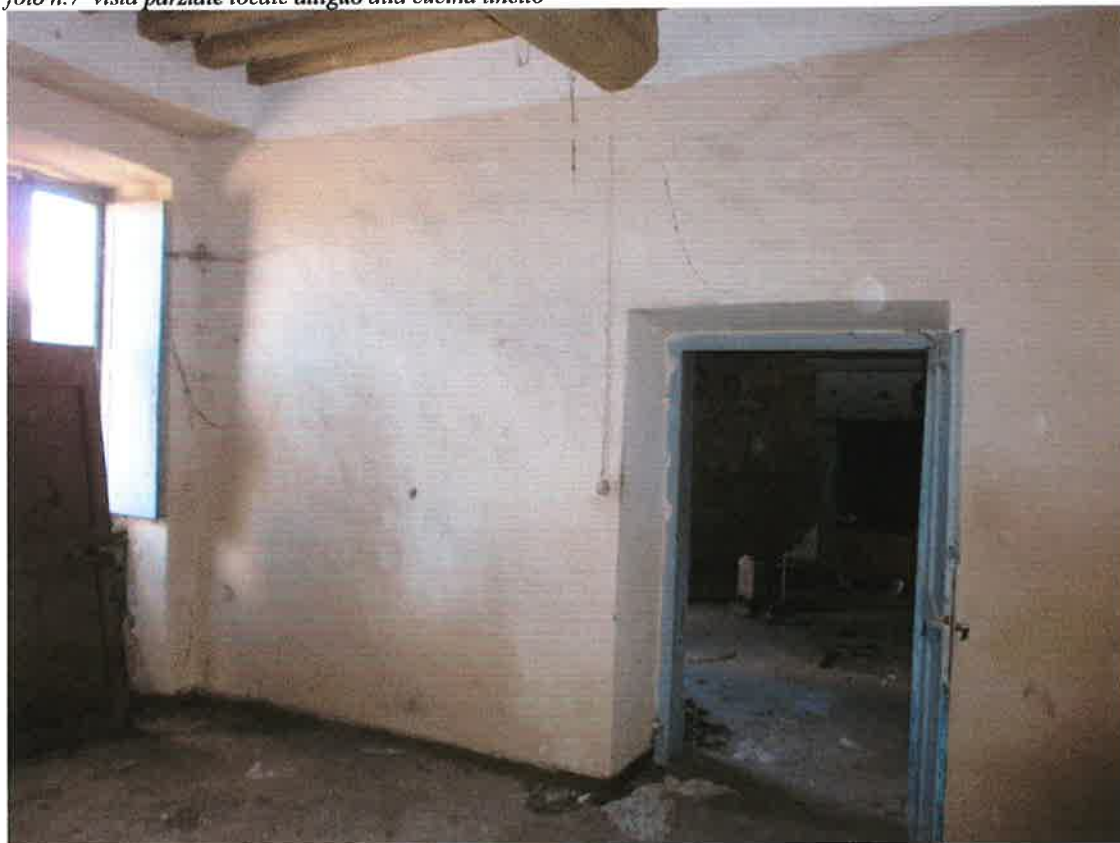
foto n.8 vista arrivo scala primo locale
