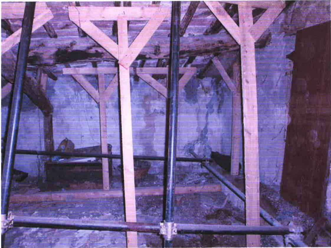
foto n.1 ingresso via impegolato 18
