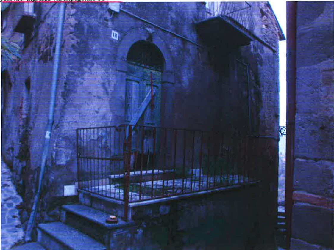
foto n.2 vista scala ingresso
