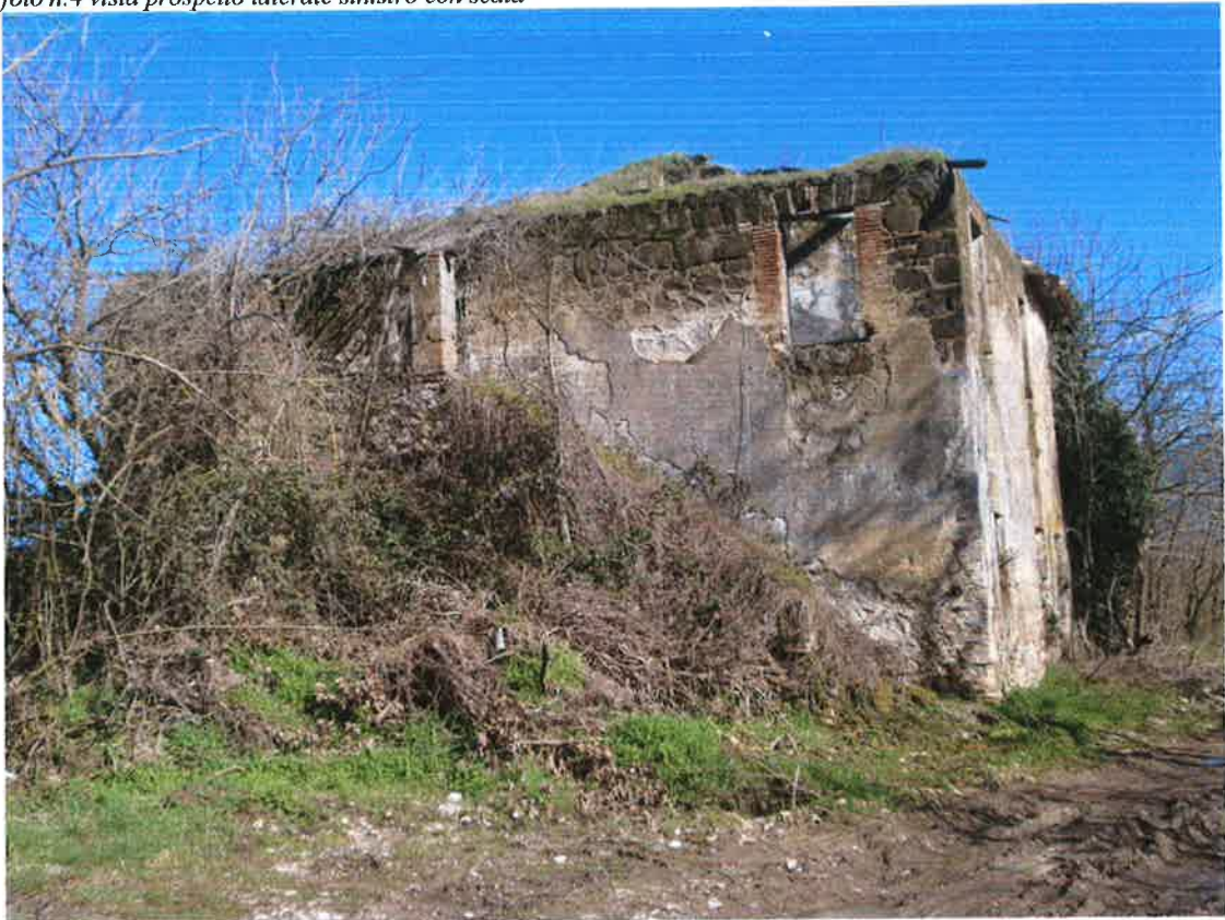
foto n.5 vista retro prospetto e ingresso secondario stalla
