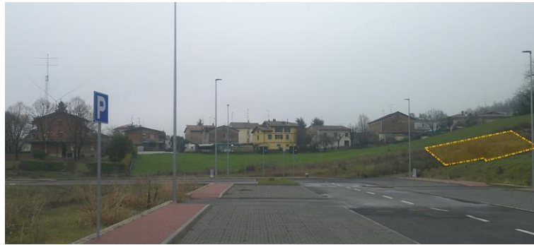
Figura 10: Vista del lotto oggetto di pignoramento da Via David Sassoli. Si segnala che il lotto è in pendenza, pertanto per edificare occorrerà sbancare ed eseguire un muro di sostegno.
