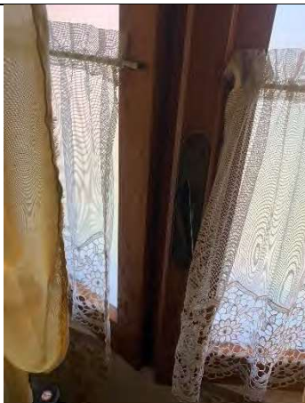
Vista degli infissi esterni piano primo
