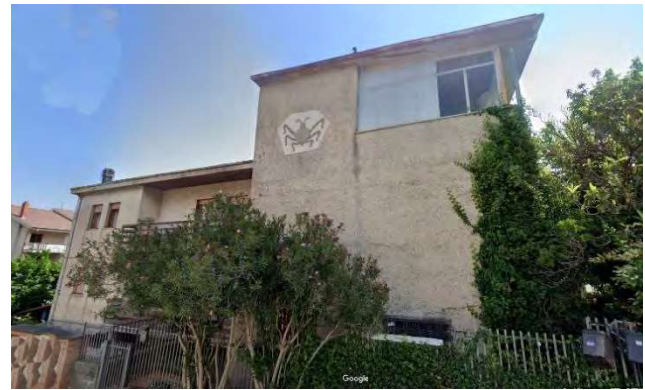
Vista dell'immobile – fronte OVEST
