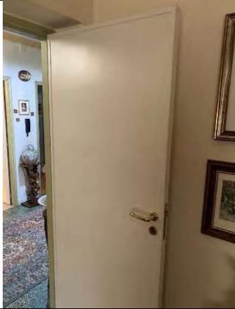
Vista degli infissi interni piano primo
