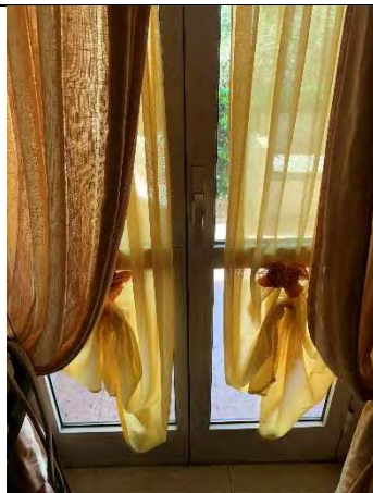
Vista degli infissi esterni piano primo
