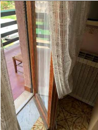
Vista degli infissi prima camera da letto piano primo rialzato
