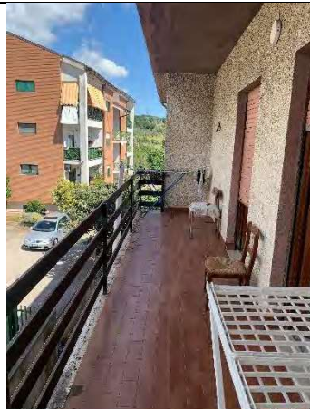
Vista del balcone della zona notte piano primo rialzato
