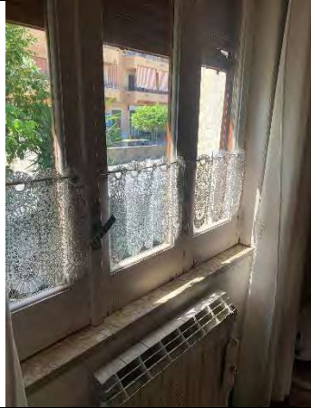
Vista degli infissi esterni piano primo
