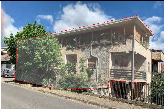
Vista dell'immobile da via De Chirico – fronte SUD
