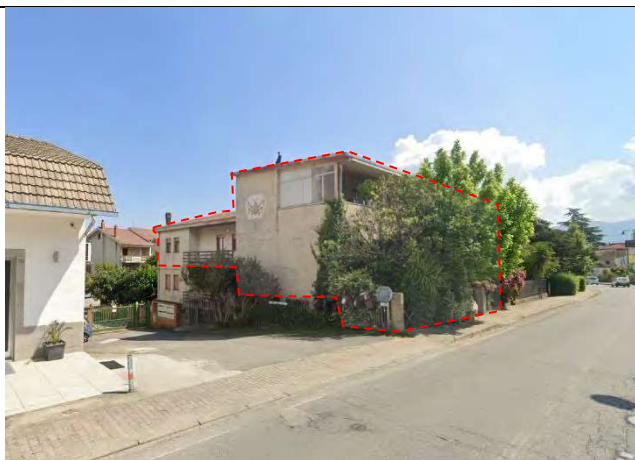
Vista dell'immobile da via De Chirico – fronte OVEST
