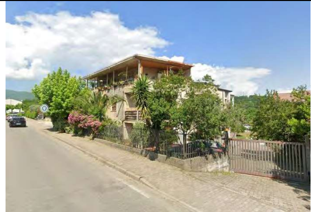
Vista dell'immobile da via De Chirico – fronte EST
