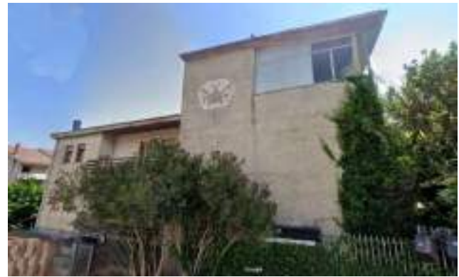
Vista dell'immobile – fronte OVEST
