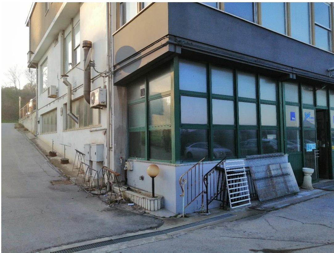
Foto n. 8 scivolo d'accesso al laboratorio artigianale (distinto al Catasto fabbricati al foglio 88 particella 41 sub 8) da quota piazzale ingresso e prospetto d'ingresso del locale artigianale
