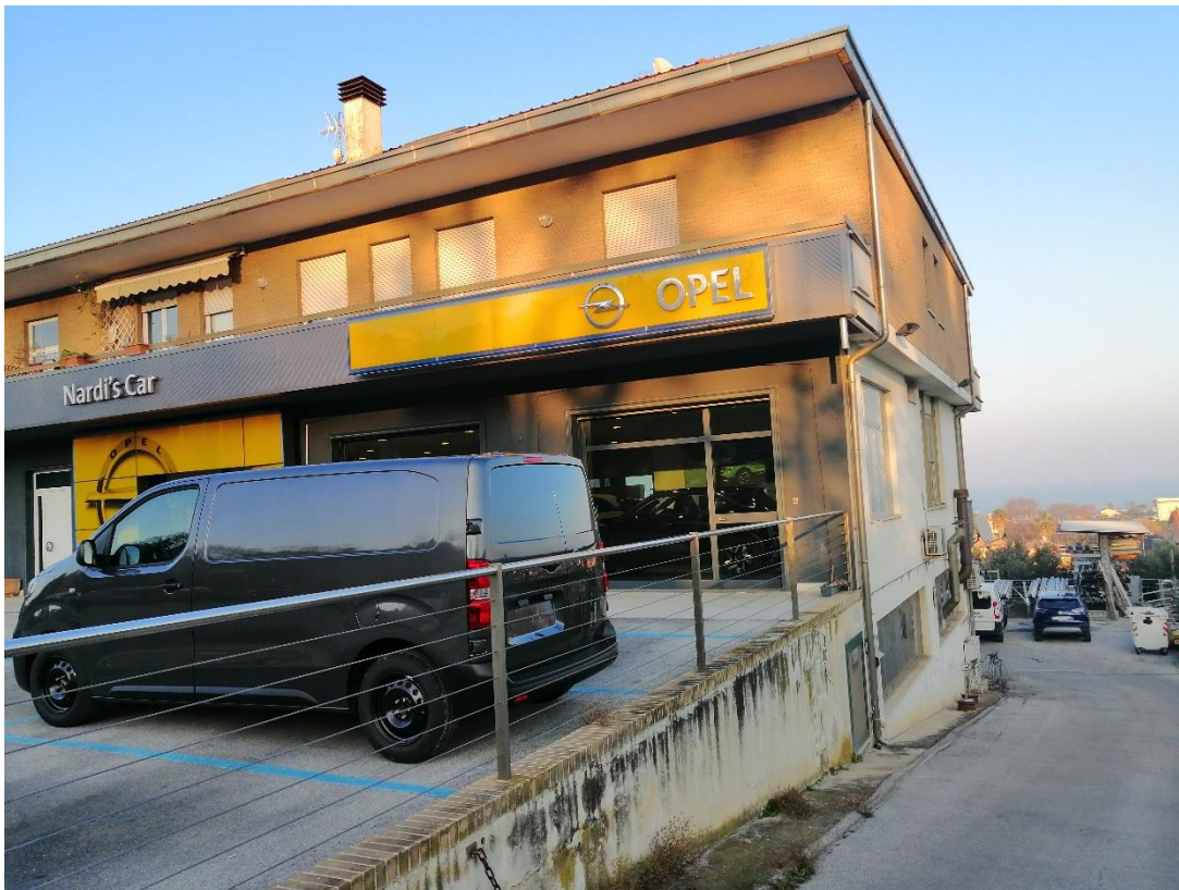
Foto n. 7 scivolo d'accesso al laboratorio artigianale (distinto al Catasto fabbricati al foglio 88 particella 41 sub 8) da quota strada statale
