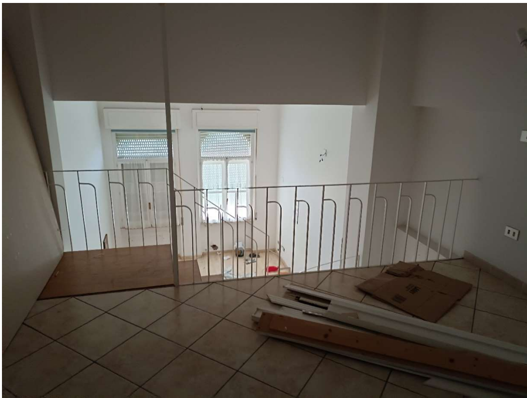
Foto n. 13 –piano ammezzato Sub 100
